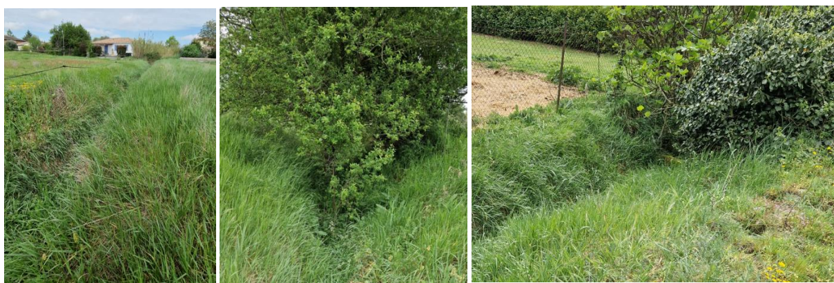
Figure 17 : photos du fossé
