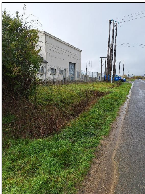
Figure 11 : Fossé exutoire au droit de la départementale D84, au Sud du PS
