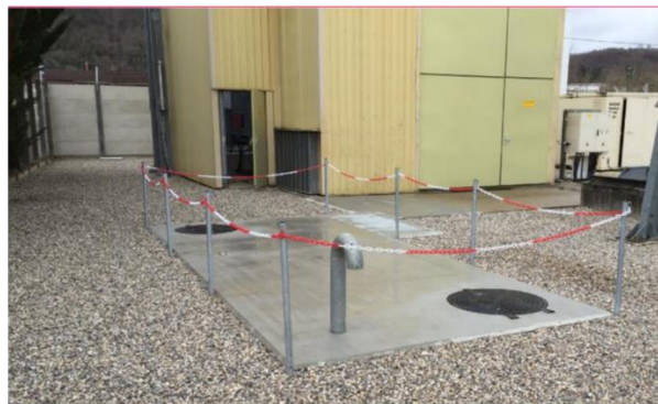
Figure 5 : Coupes et photographie d'une fosse déportée type (source ENEDIS)
