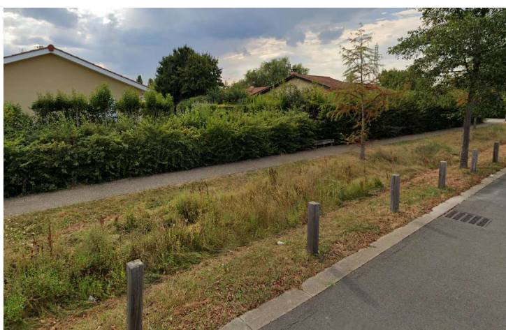
Figure 49 : Noue le long de l'Avenue des Explorateurs (lotissement Balmont)
