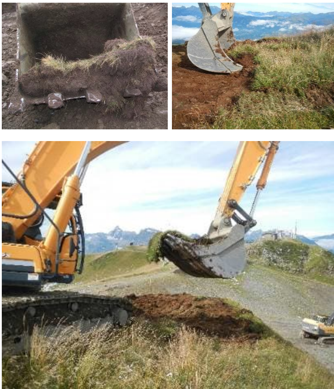
Photo 15 Exemple de déplaçage de mottes à la pelle mécanique et godet « classique »
