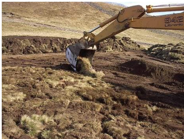
Photo 17 Exemple de remise en place de mottes à la pelle mécanique en zone de replat
