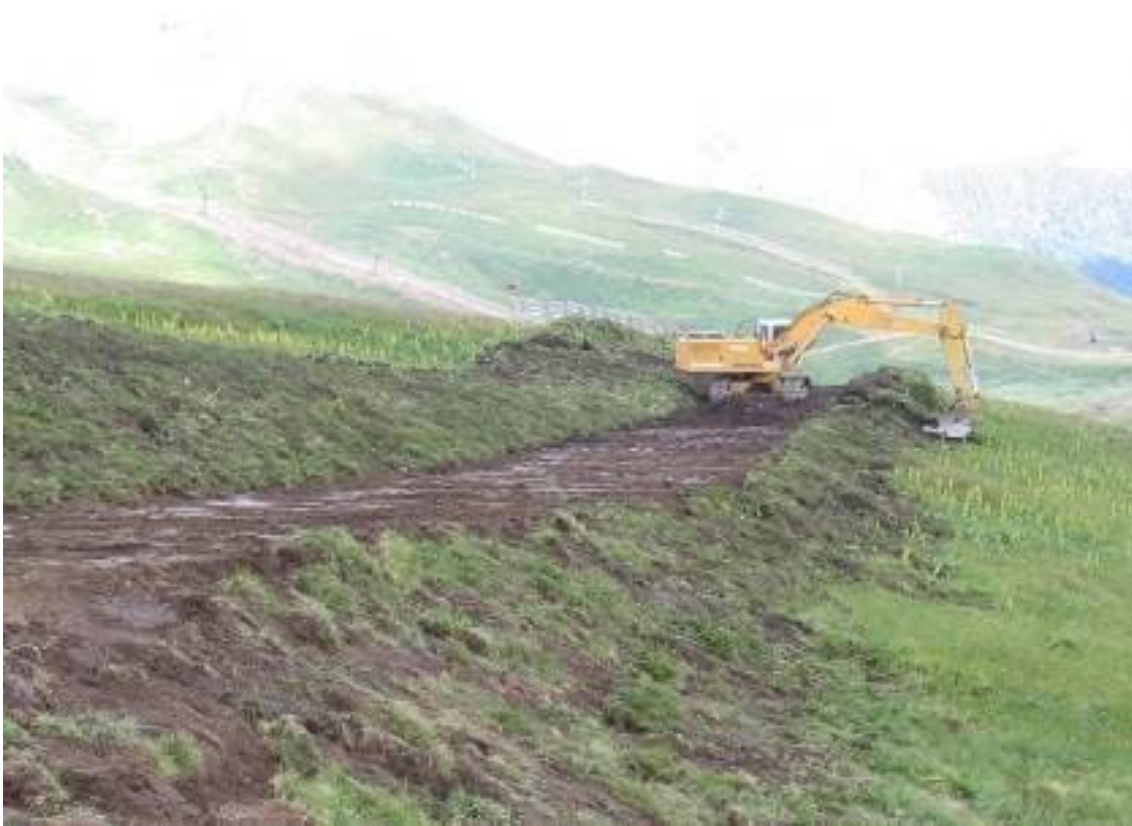
Photo 18 Exemple de remise en place des mottes en talus terrassés
