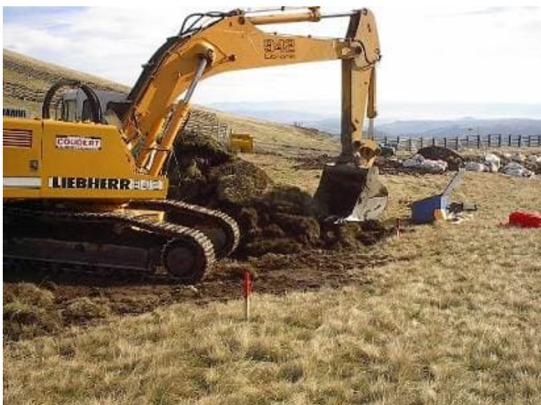
Photo 16 Exemple de stockage de mottes à la pelle mécanique en bordure d'emprise
