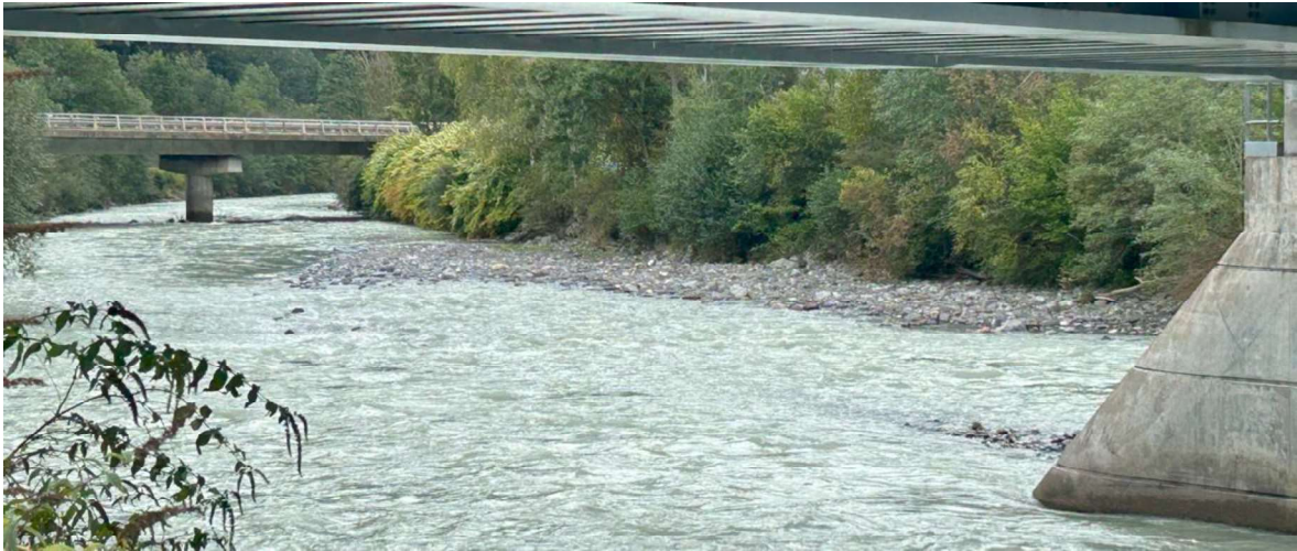
Figure 2 : Vue de la digue d'Oëx, en rive droite, et du cordon rivulaire, entre le pont ferroviaire (premier plan) et le pont de l'A40 (second plan)
