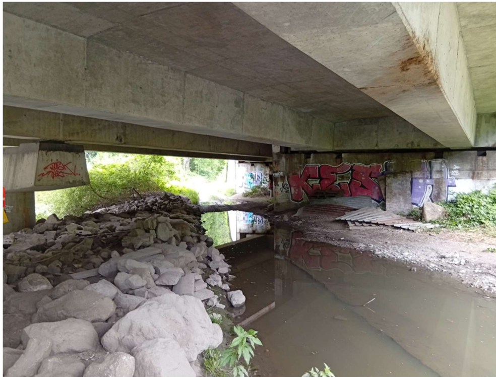
Figure 4 : Accès agricole sous le pont de l'A40 - ATMB (source : Hydrétudes)
