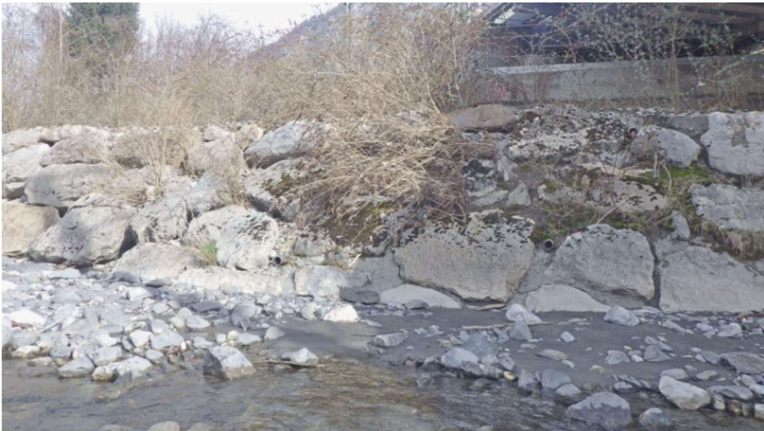
Figure 7 : Photographie du site - vue sur la berge en rive droite en prolongement du Pont SNCF (Inspection 2024 des appuis immergés du pont ferroviaire sur l'Arve – Ligne 895000 PK 35+544)
