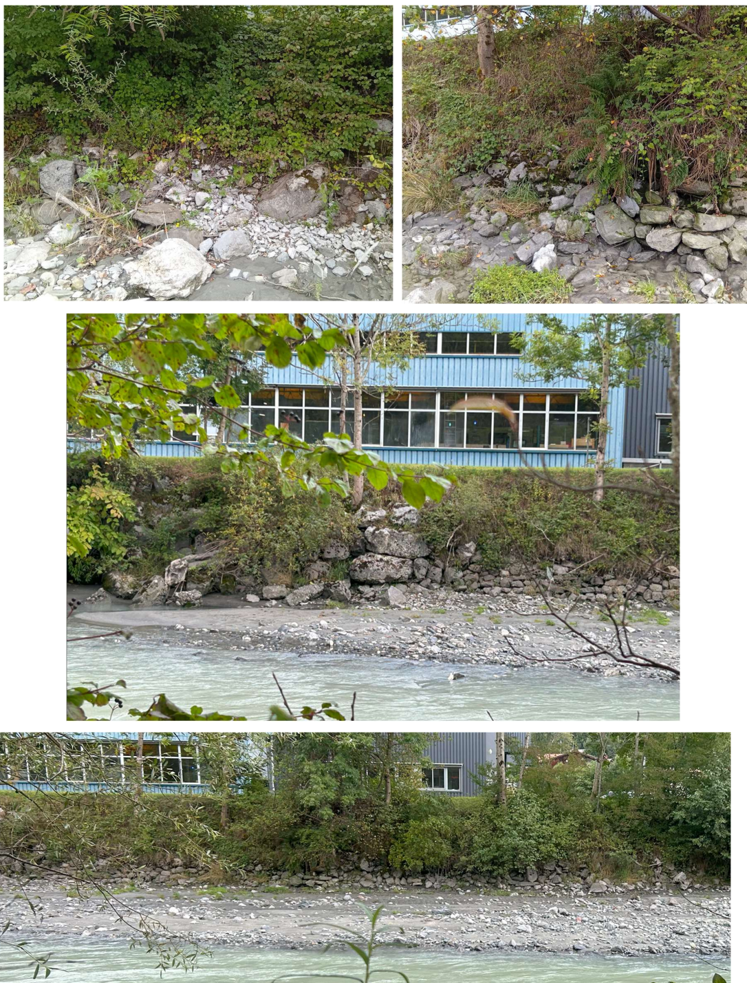
Figure 14 : Photographies du site - vue sur la digue existante le long de la zone d'étude
