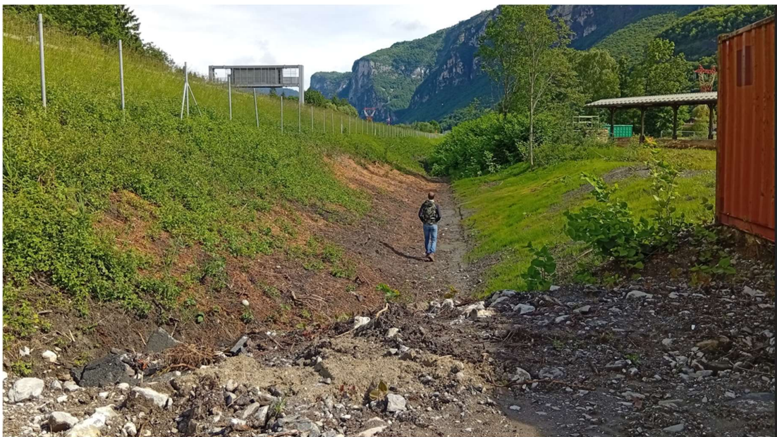
Figure 36: Fossé de drainage le long de l'A40 à l'aplomb de l'usine BG TP
