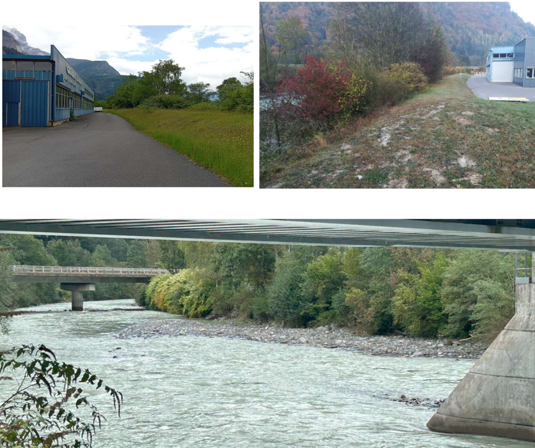
Figure 2 : Digue d'Oëx – Gradel Baudin (source : Hydrétudes- 2025)
