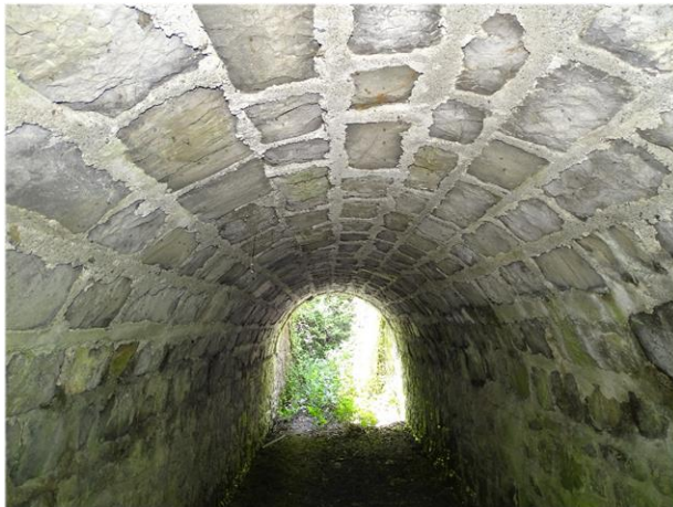
Vue sous le tunnel (23 juin 2025)
