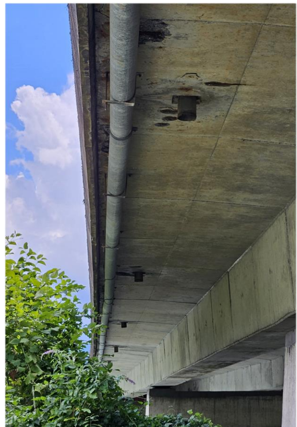
Vue sous le pont autoroutier à l'ouest (23 juin 2025)
