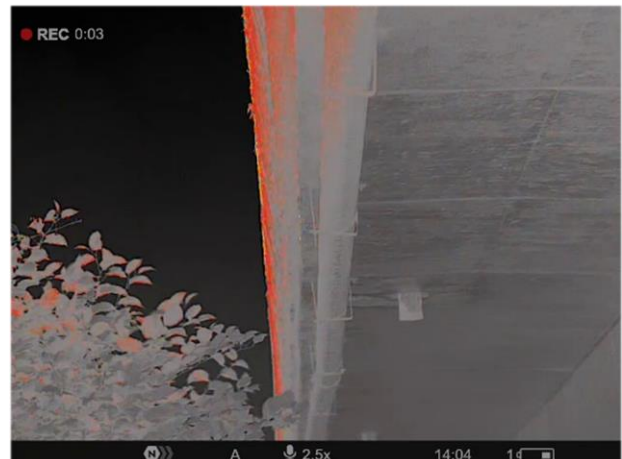
Analyse thermique du pont autoroutier à l'ouest (23 juin 2025)
