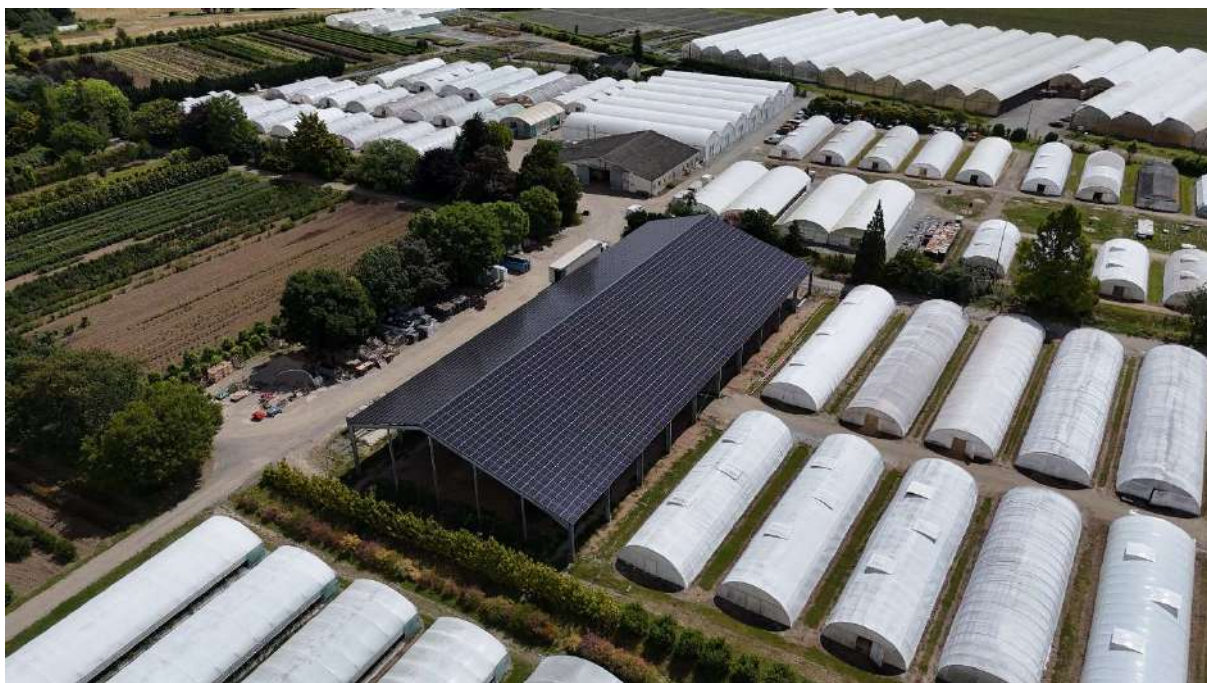
Hangar de stockage agricole
