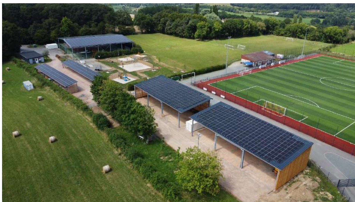
Structures bardées couvrant un bouledrome (et au loin un court de tennis + des ombrières de parking)
