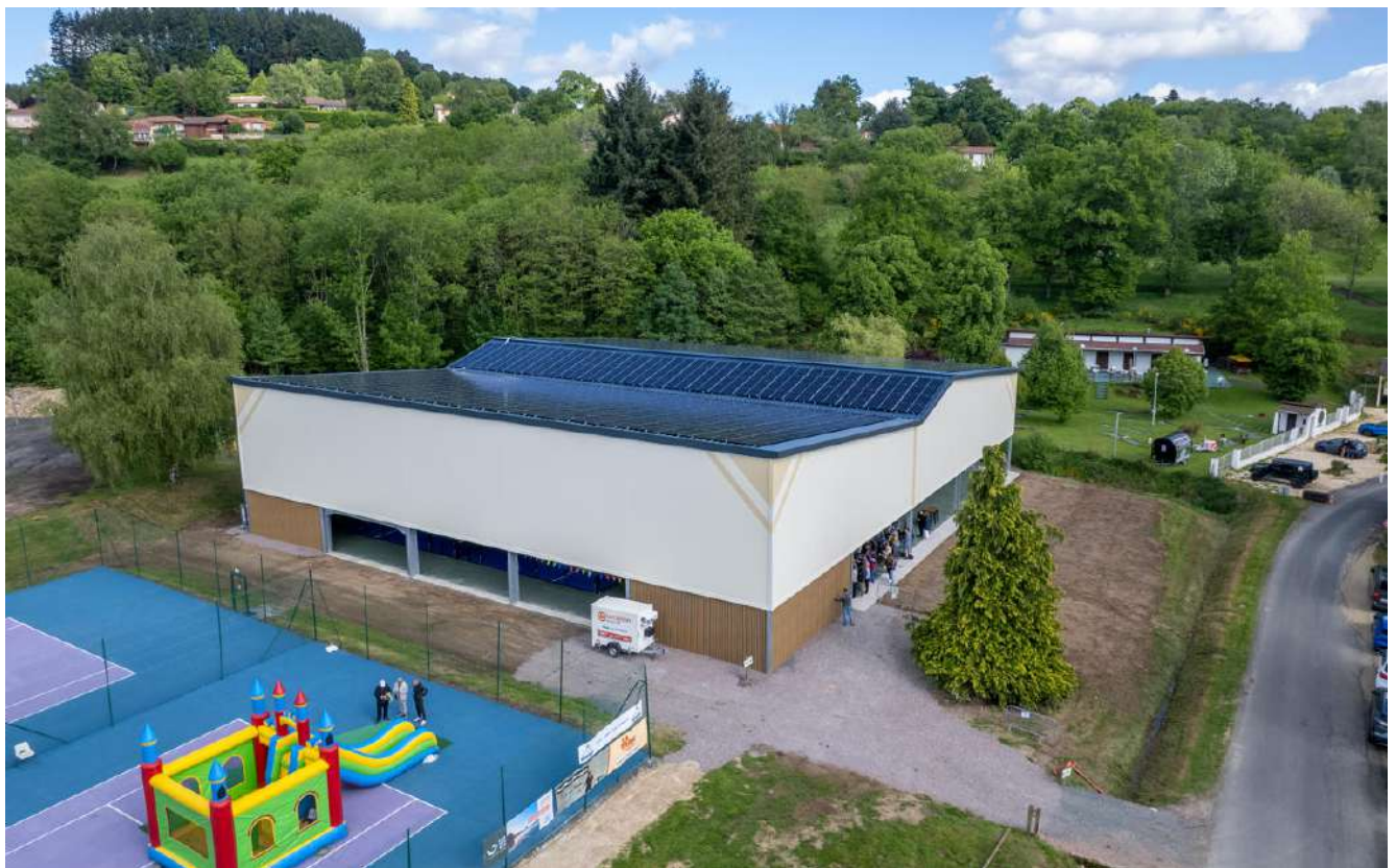
Structure bardée en toile tendue couvrant 3 terrains de Padel
