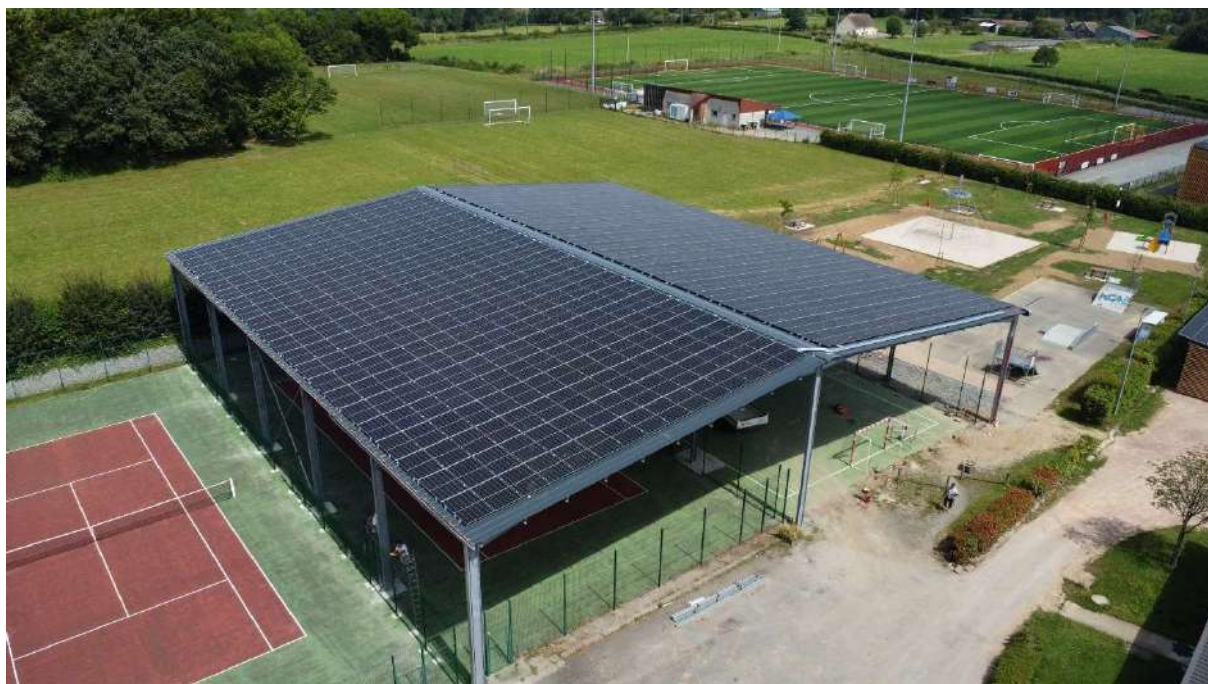
Structure double couvrant un court de tennis
