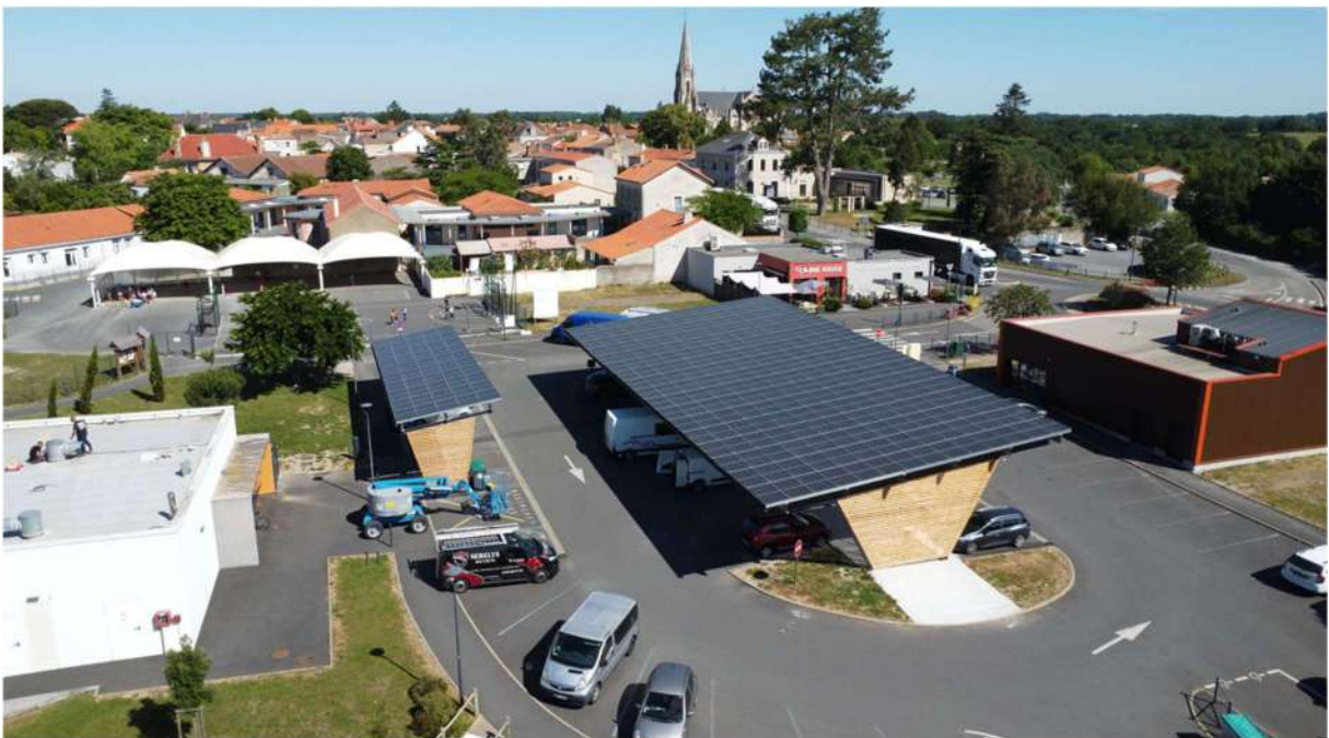
Ombrières avec bardage bois
