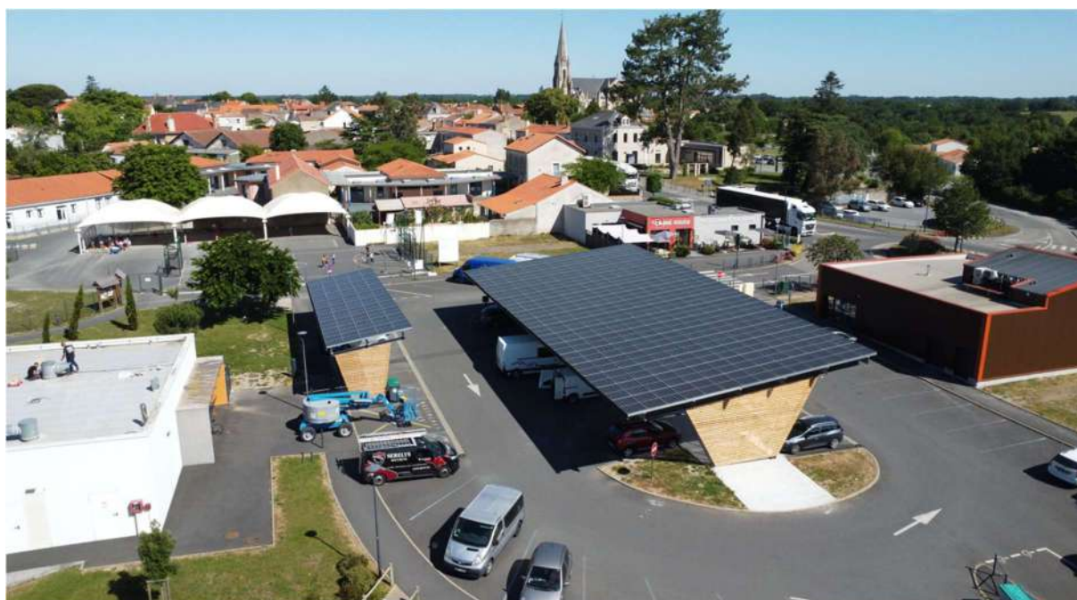
Ombrières avec bardage bois
