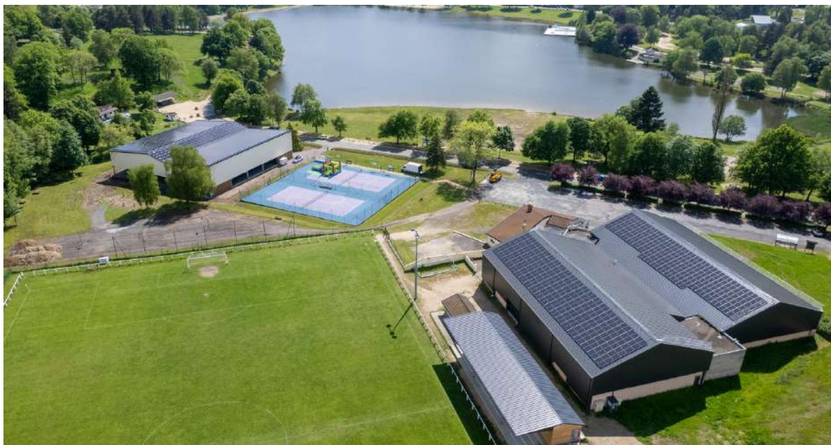
Structures photovoltaïques s'intégrant harmonieusement à leur environnement
