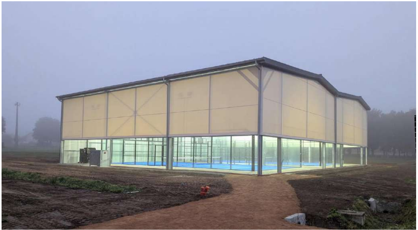
Structure bardée en toile tendue couvrant 2 terrains de Padel
