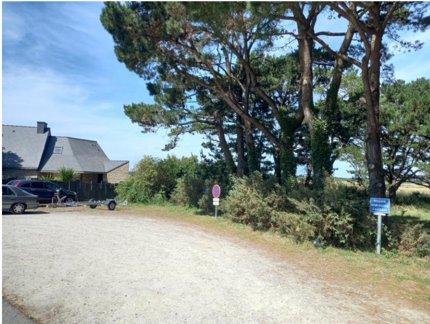
Photo 1 : départ du forage dirigé, août 2025
