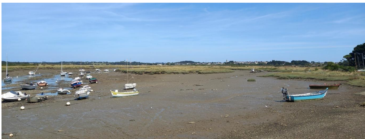
Vue 1 : l'étier de Billiers (marée basse) sous lequel passera le forage dirigé. Vue prise en direction du nord depuis le port de Pen Lan (localisation des vues sur plan en annexe 1)
