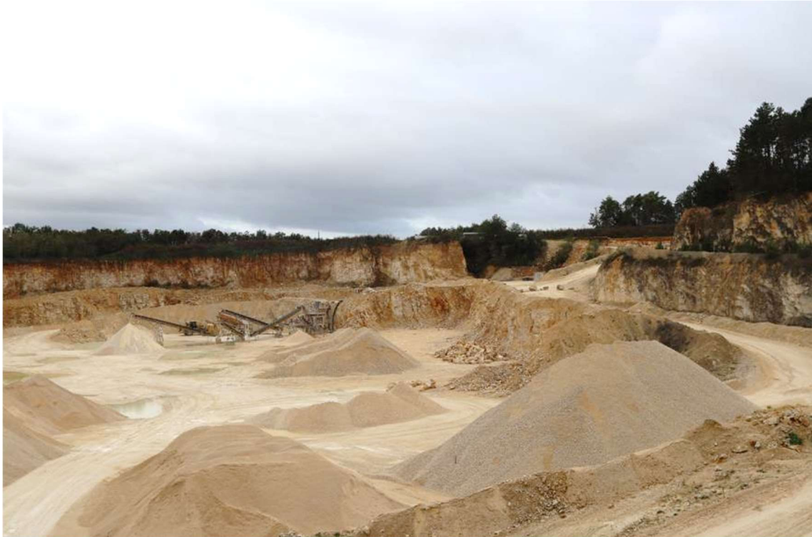
Photo n°1 : Vue générale de la fosse d'extraction et de l'installation de traitement
