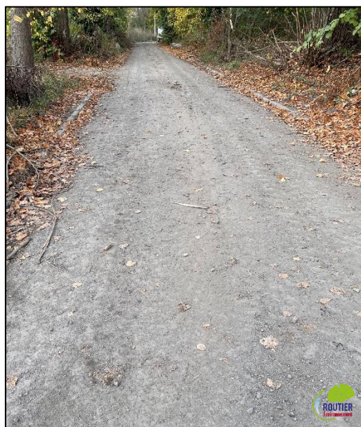
Figure 17 : Photographie de l'accès au site
