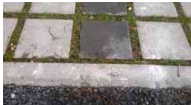
Exemple de pavés à joints engazonnés
