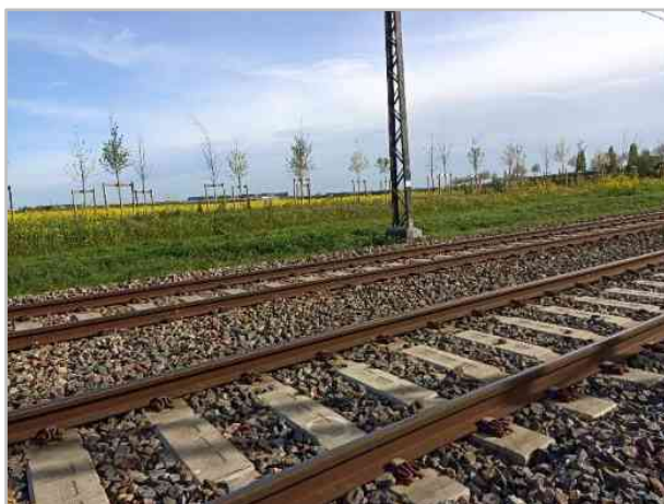
Photo 9 : Ballasts ferroviaires © Rainette, 2025
