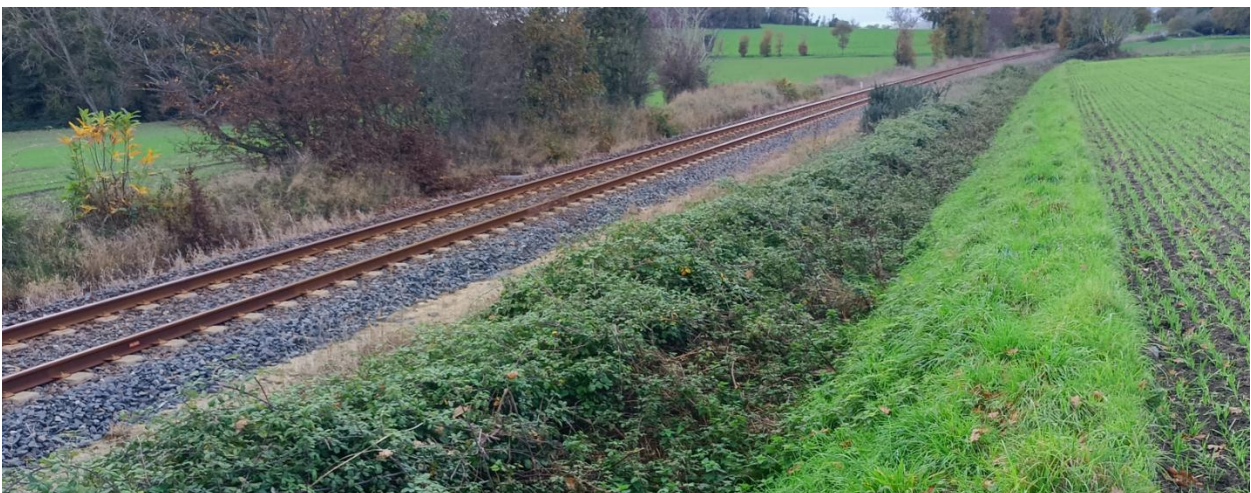
Le fossé et la voie ferrée en limite Est du site d'étude (vue du Nord vers le Sud).
