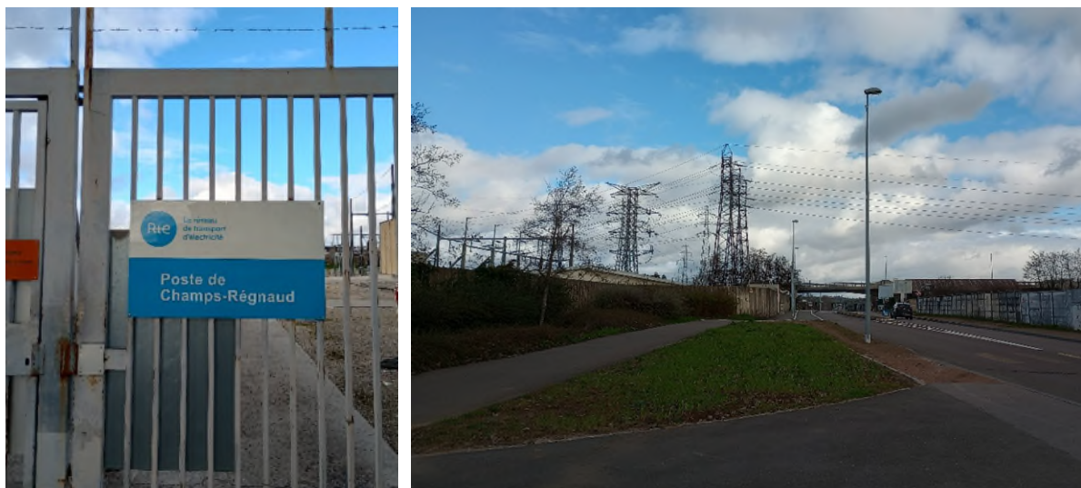
Figure 56 : Poste électrique RTE de CHAMPS-REGNAUD (source : EGIS mars 2024)
