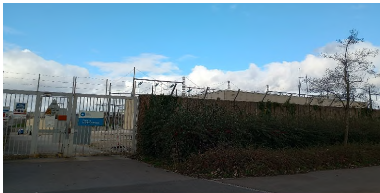
Figure 18 : Poste électrique de CHAMPS-REGNAUD au Nord de Dijon (source : Egis, 2024)
