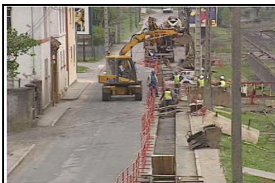
Figure 30 : Phase de chantier en zone urbaine (source : RTE)
