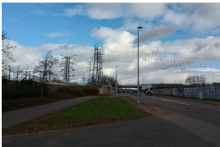
Figure 20 : Avenue de Stalingrad montant vers le Nord, poste électrique de CHAMPS-REGNAUD à l'Ouest de la photo (source : Egis, 2024)
