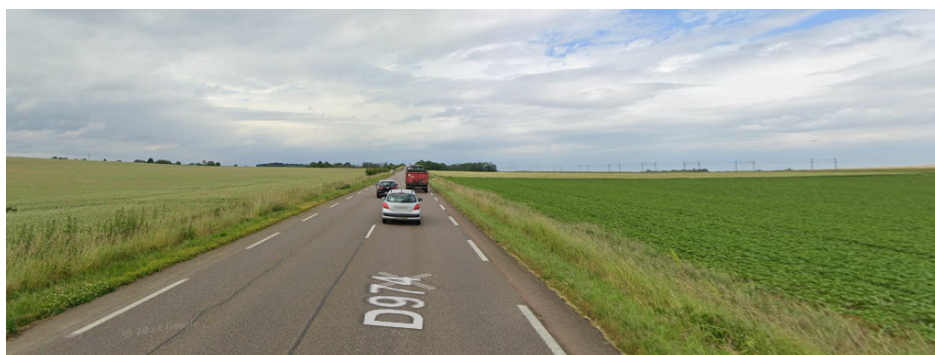
Figure 22 : RD974 au niveau de l'élargissement du tronçon Ouest (source : Google Street View, juin 2024)
