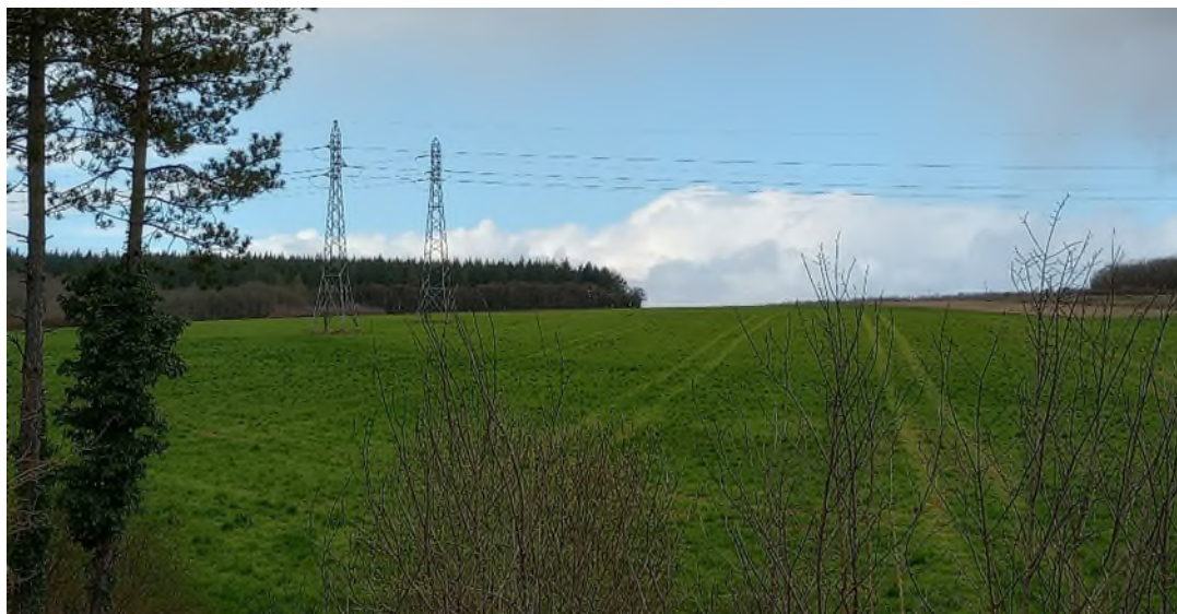
Figure 54 : Champs et pylônes électriques en bordure de la RD74 entre Norges-la-Ville et Asnières-lès-Dijon (source : EGIS mars 2024)
