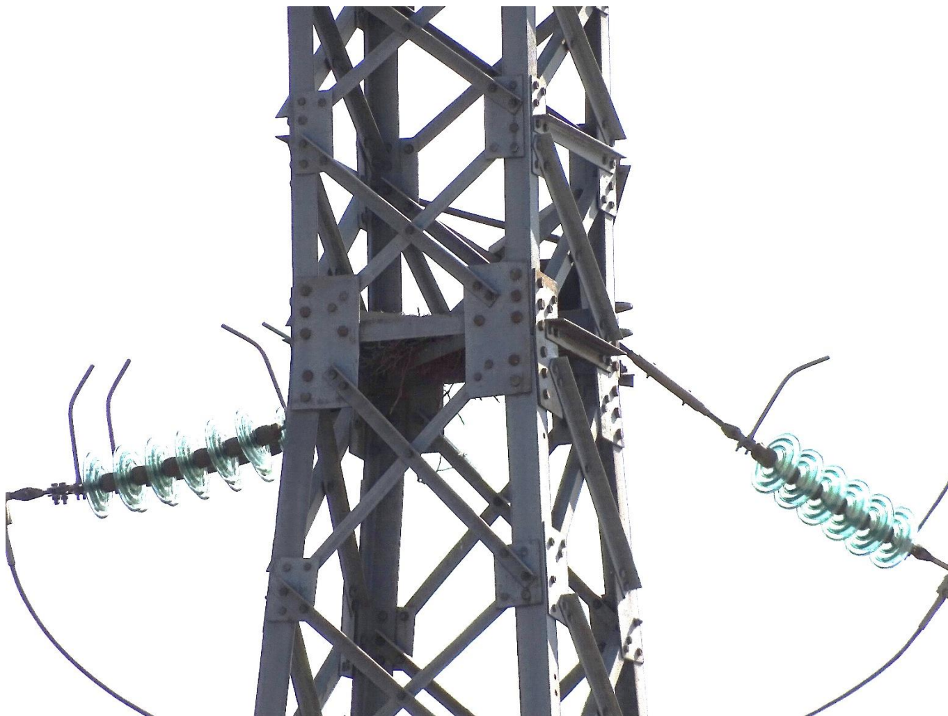
Figure 15 : Nid utilisé par le Faucon crécerelle sur le pylône électrique du poste électrique de CHAMPS-REGNAUD
