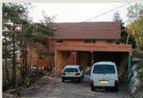
accès latéral, par le haut, parallèlement aux courbes de niveau on peut remarquer la réalisation du soutènement des talus créés
