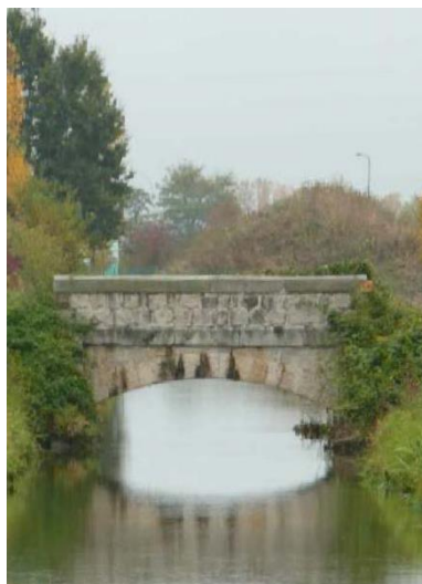
Pont en pierre XIXe siècle Photo Archipat
