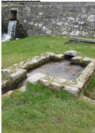
Petit lavoir à ciel ouvert Photo Archipat
