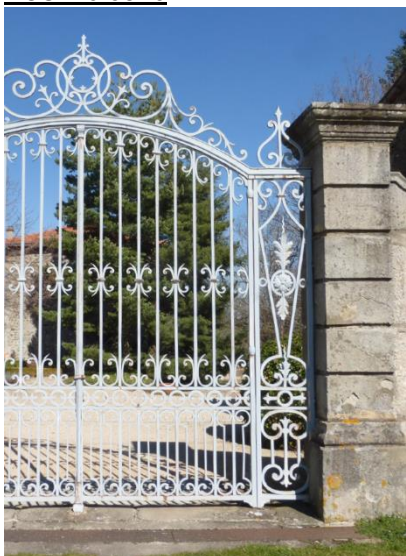
Portail en fer forgé peint Photo : Archipat
