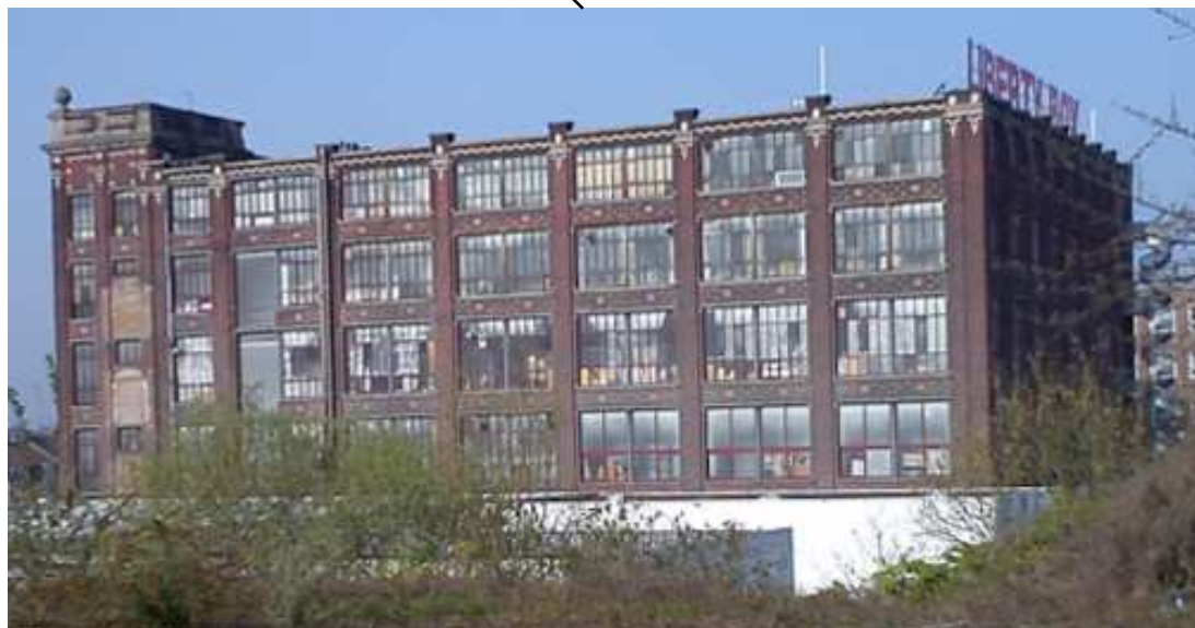
Photographie 12 : Usine au 39 boulevard du Luxembourg
