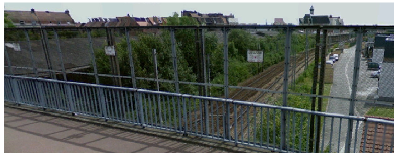
Photographie 15 : Vue des voies ferrées depuis l'avenue des Nation Unies
