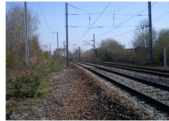
Vue 1 : Les abords de la voie ferrée
