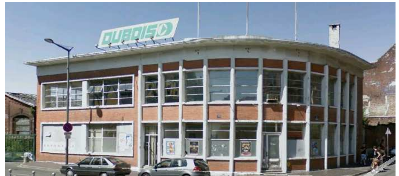
Photographie 13 : Bâtiment Dubois
