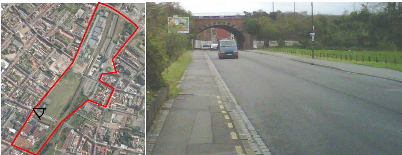
Photographie 5 : Vue de la rue de Mouvaux
