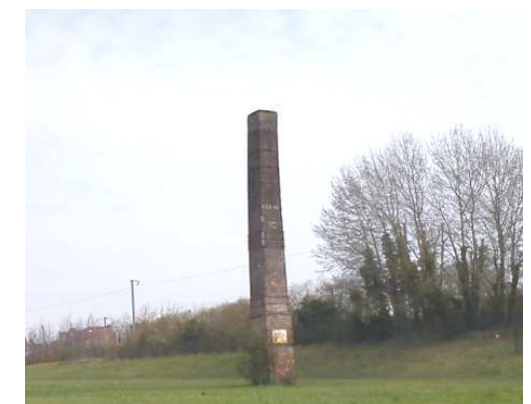
Vue 4 : Cheminée industrielle rue de l'Ouest
