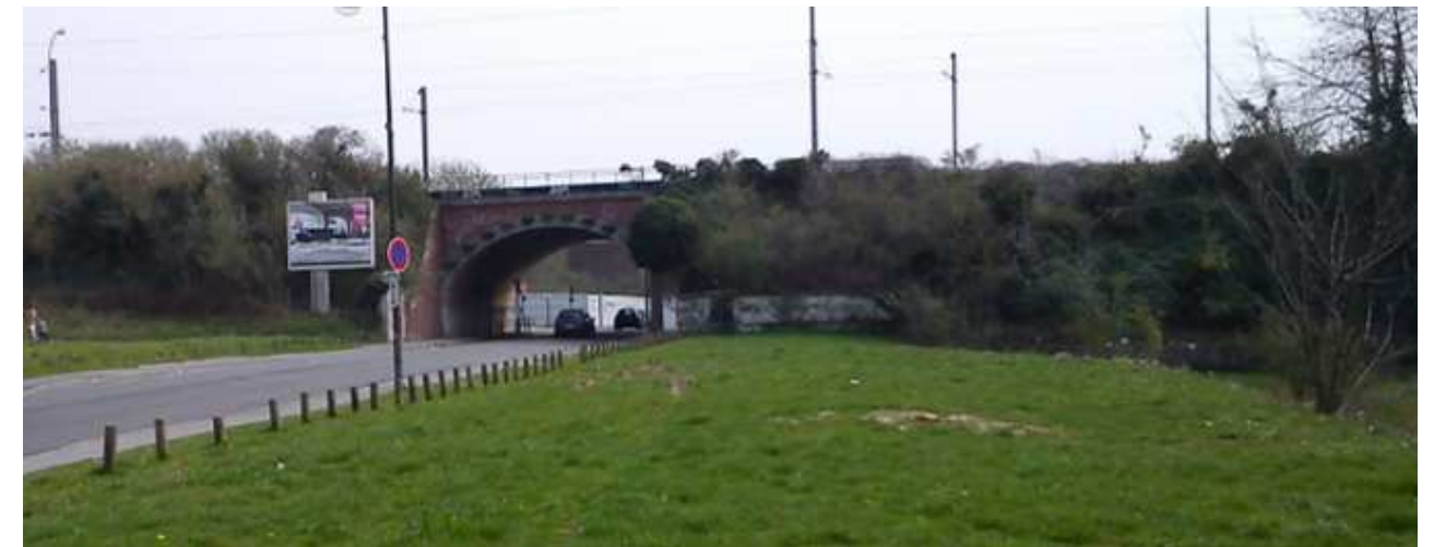
Photographie 17 : Vue du talus RFF depuis la rue de Mouvaux
