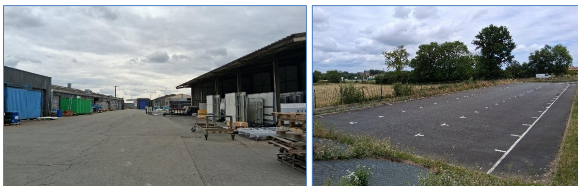
Figure 25 : Photographies des bâtiments de PROCAR et du réseau routier [AGGRA Concept, 30 Juillet 2025]
