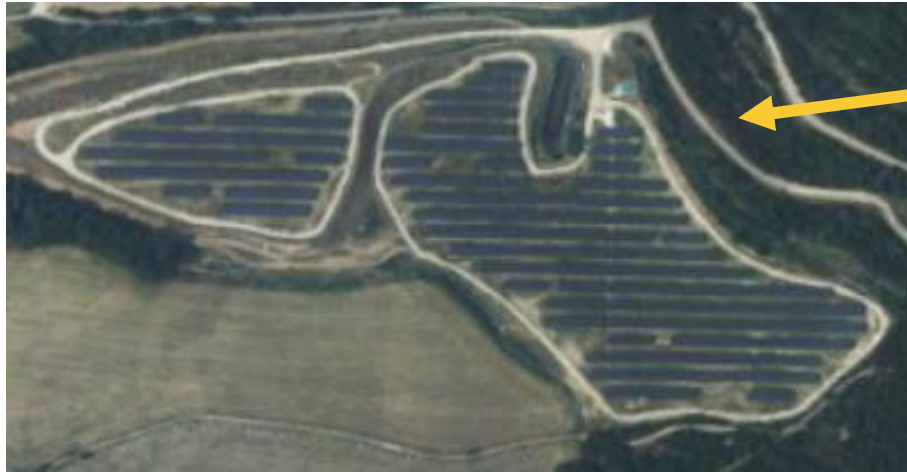
Centrale PV de Saint-Romain-en-Gal
