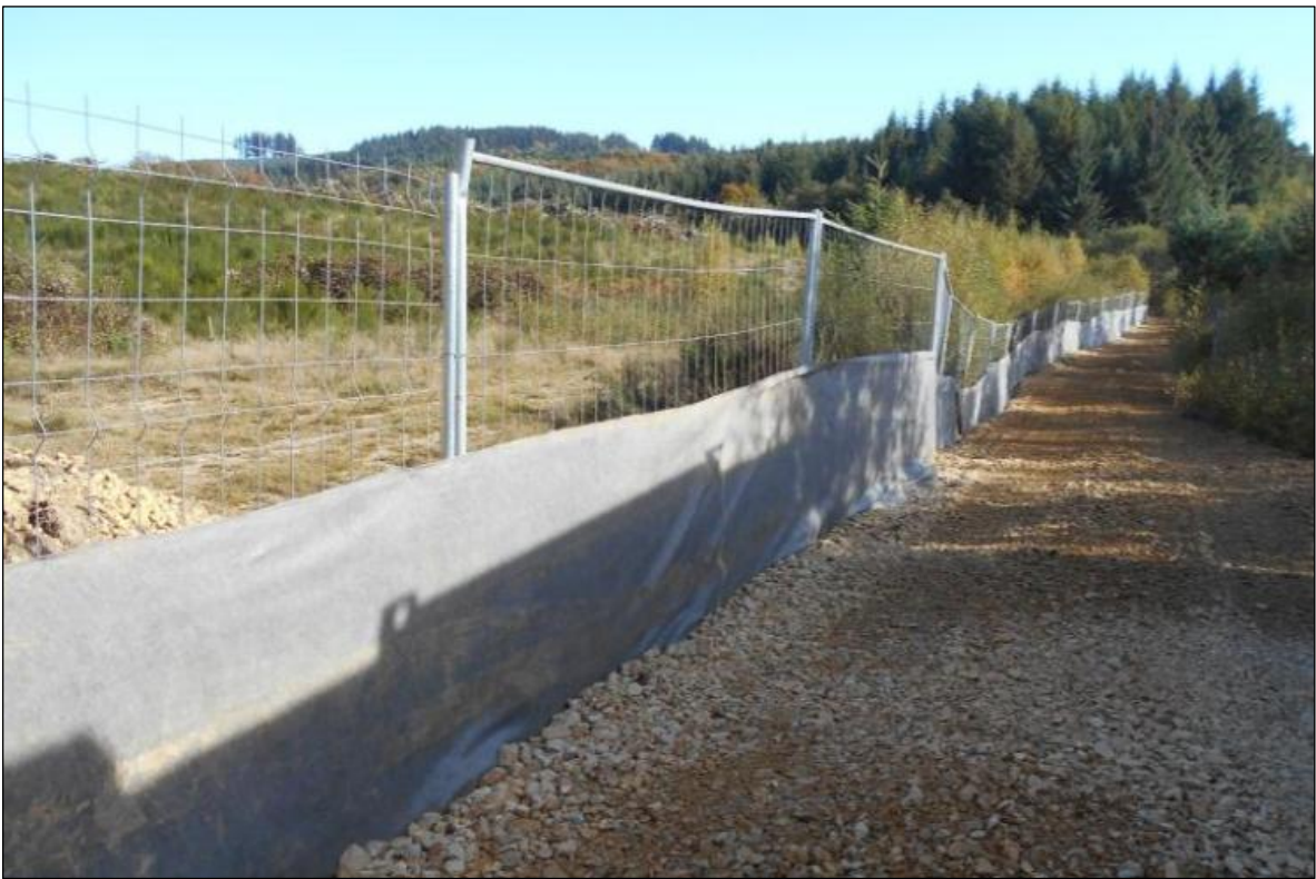
Exemple de mise en place d'une clôture de chantier avec géotextile en pied de mise en défens pour éviter à la faune de pénétrer sur l'emprise du chantier
