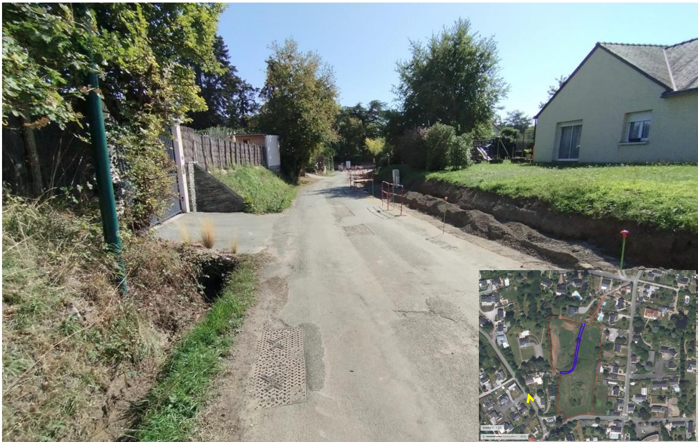
Vue de la rue de la Héripière encaissée par rapport aux terrains bâtis riverains (19/09/2025)
