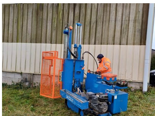
Sondage S14 (au droit de la ZS2 à l'extérieur)
