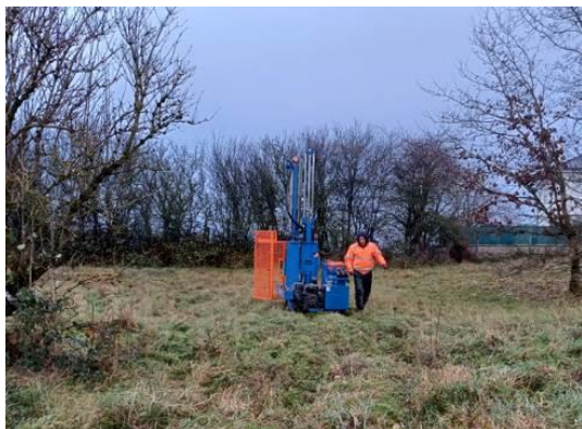
Sondage S7 (au droit de la ZS5 à l'extérieur)
