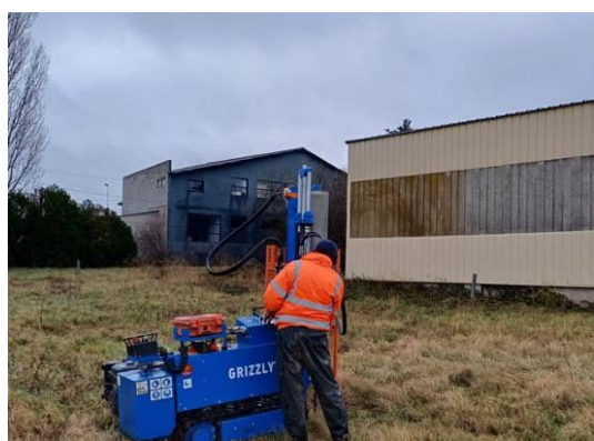
Sondage S9 (au droit de la ZS5 à l'extérieur)
