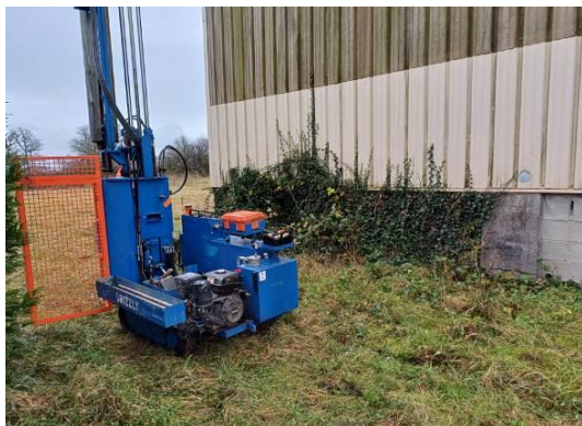
Sondage S13 (au droit de la ZS3 à l'extérieur)
