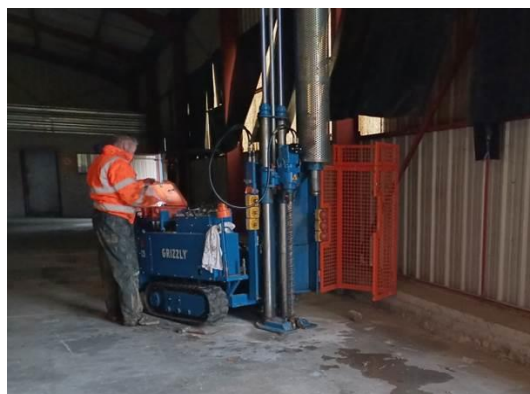
Sondage S2 (au droit de la ZS1 à l'intérieur)
