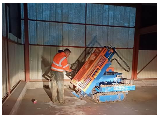
Sondage S1 (au droit de la ZS1 à l'intérieur)
