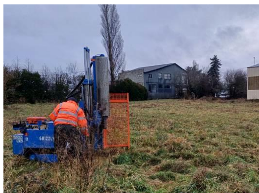
Sondage S8 (au droit de la ZS5 à l'extérieur)
