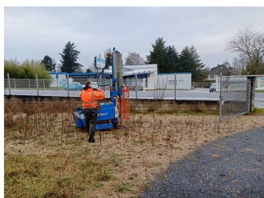
Sondage S15 (au droit de la ZS5 à l'extérieur)
