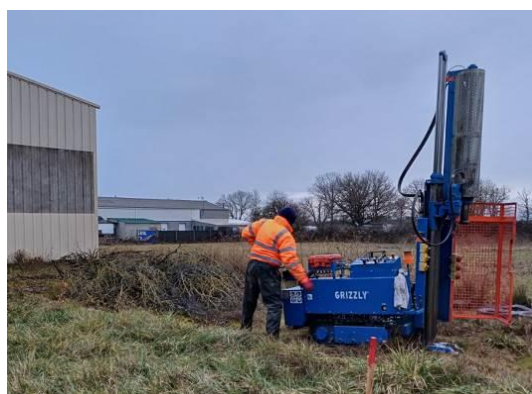
Sondage S5 (au droit de la ZS6 à l'extérieur)
