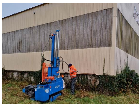
Sondage S12 (au droit de la ZS4 à l'extérieur)
