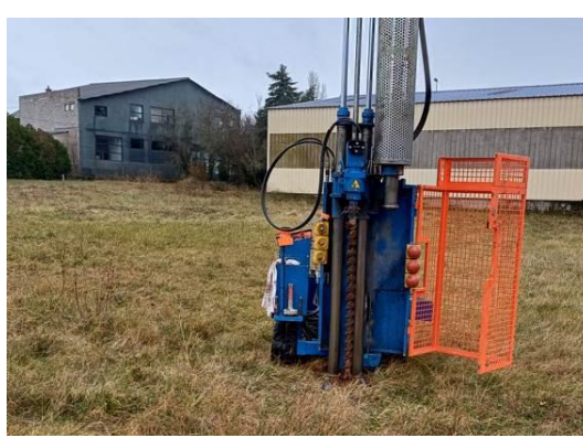
Sondage S10 (au droit de la ZS5 à l'extérieur)
