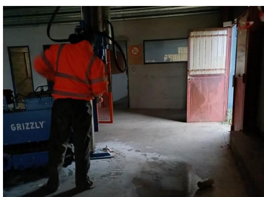
Sondage S3 (au droit de la ZS1 à l'intérieur)
