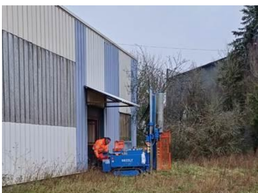
Sondage S4 (au droit de la ZS5 à l'extérieur)
