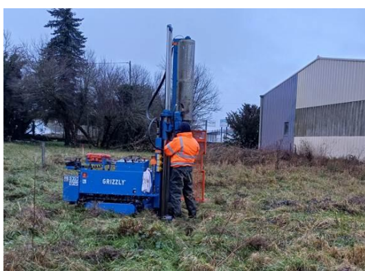
Sondage S6 (au droit de la ZS5 à l'extérieur)
