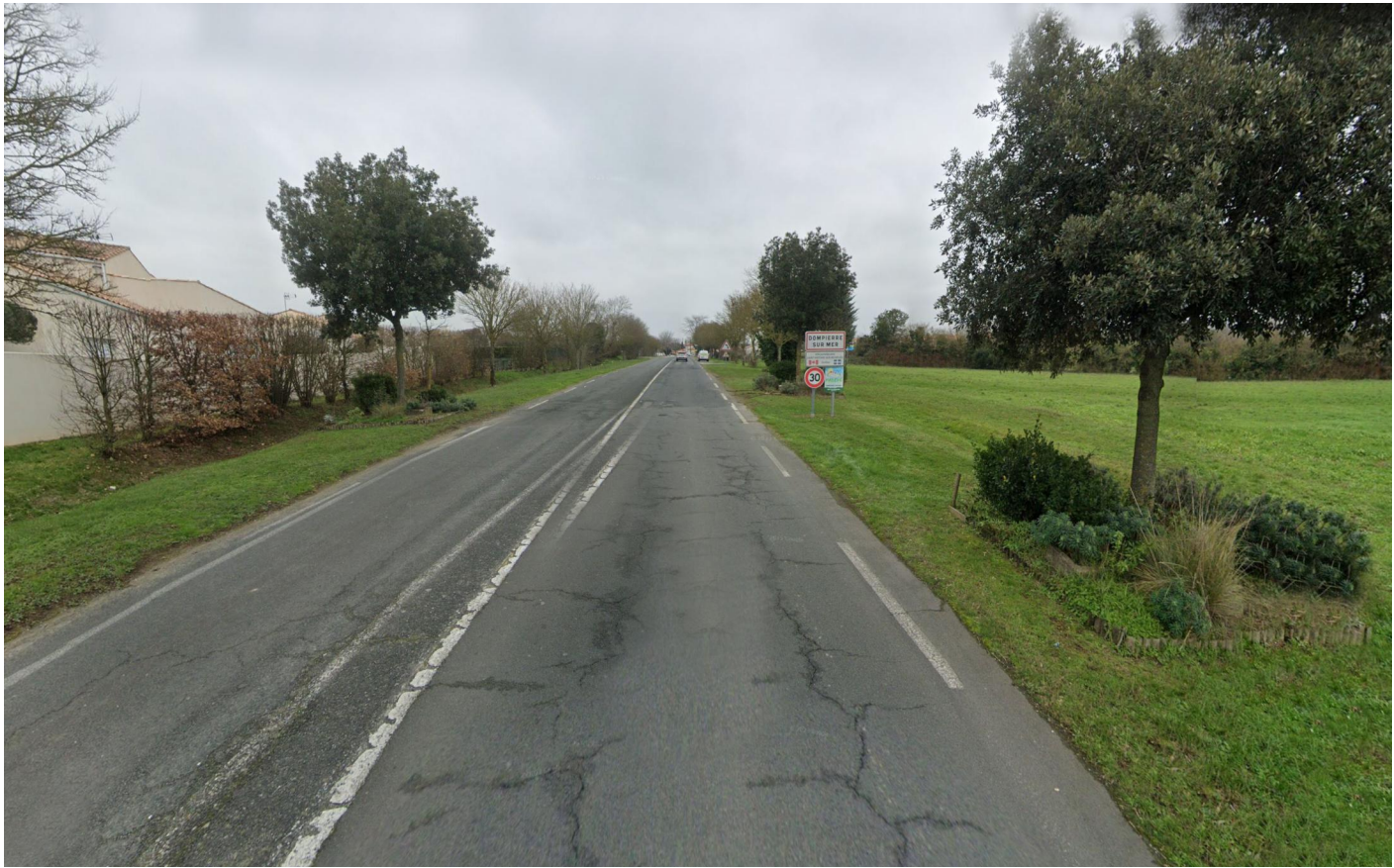
Vue 2 - Entrée de ville de Dompiere sur Mer, rue du Général de Gaulle
