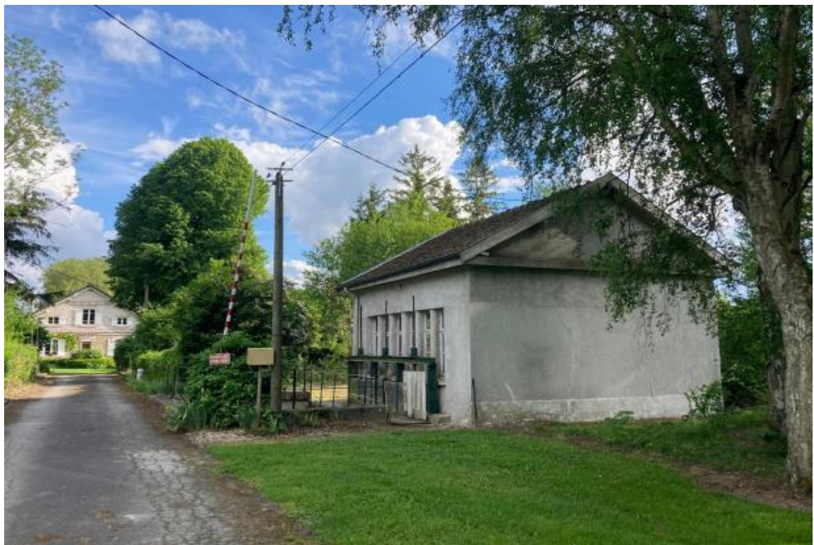
Photos récentes du bâtiment objet du projet
