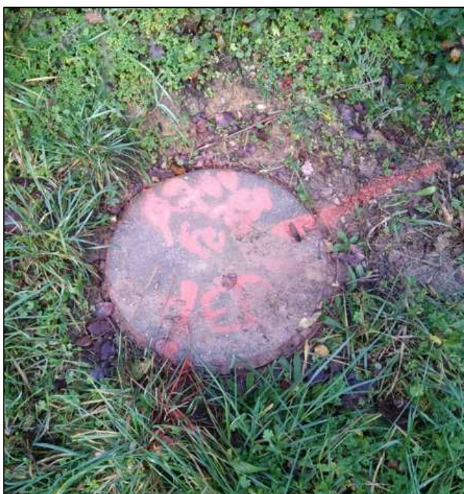
Photo 6 : Regard du cours d'eau canalisé en partie nord du site le 03/12/2025
