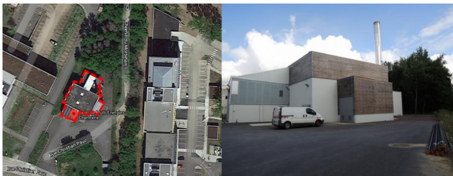
Figure 43 : Exemple de chaufferie biomasse – Ecole Polytech, Nantes – Vizea
