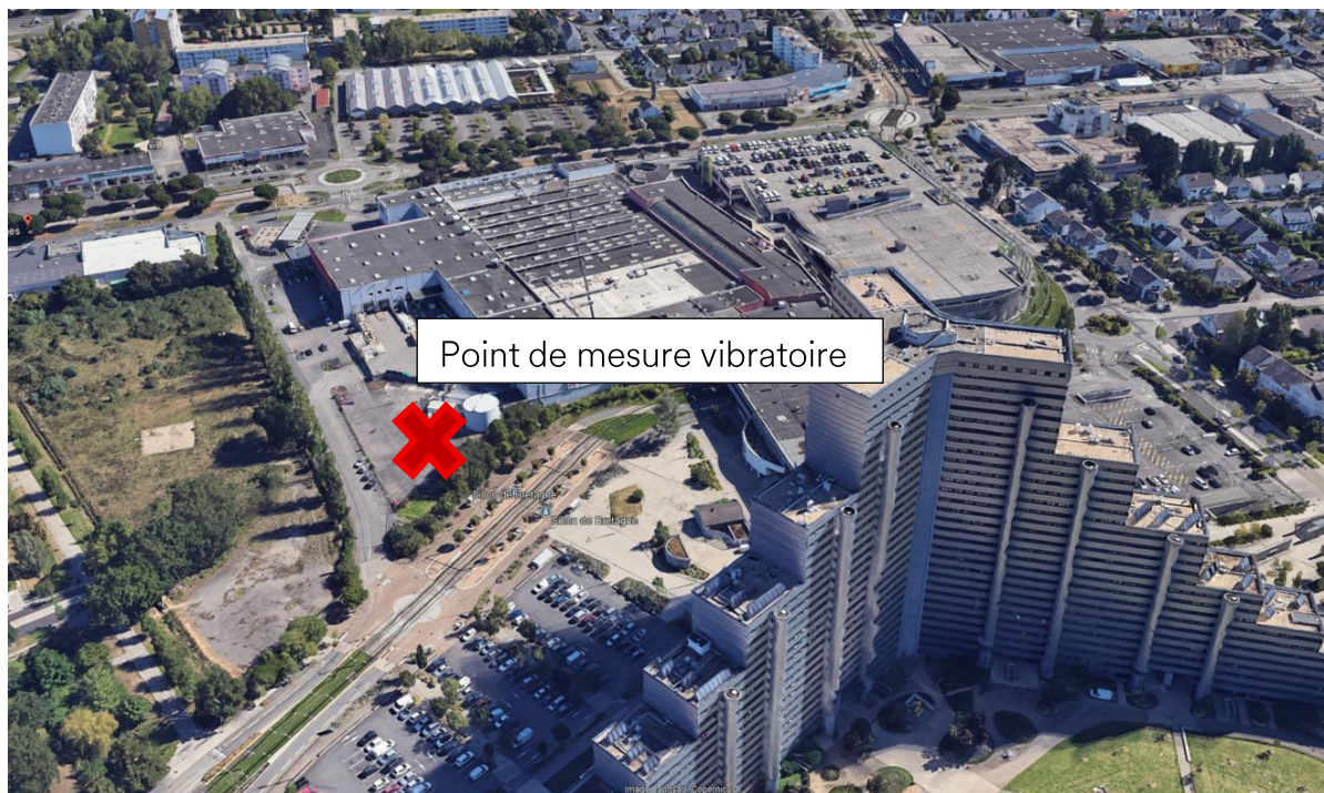
Figure 6 : Localisation du point de mesures vibratoires.
