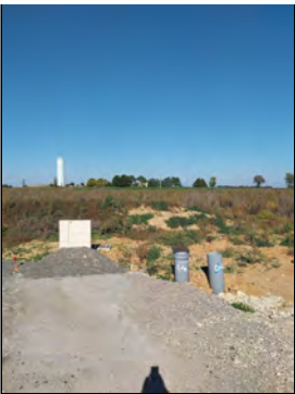
VRD en cours d'aménagement
