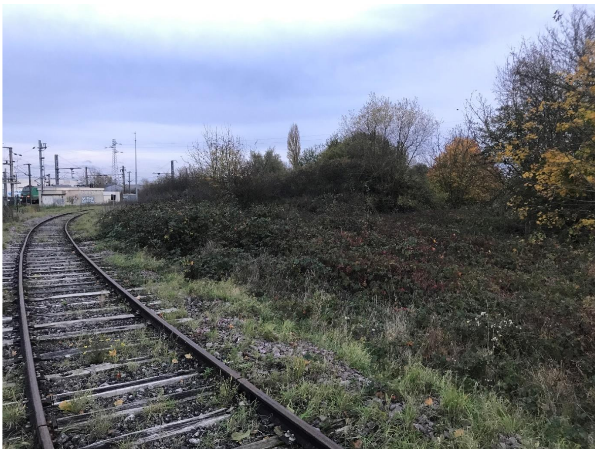
Figure 5 : Vue sur le roncier en partie Est
