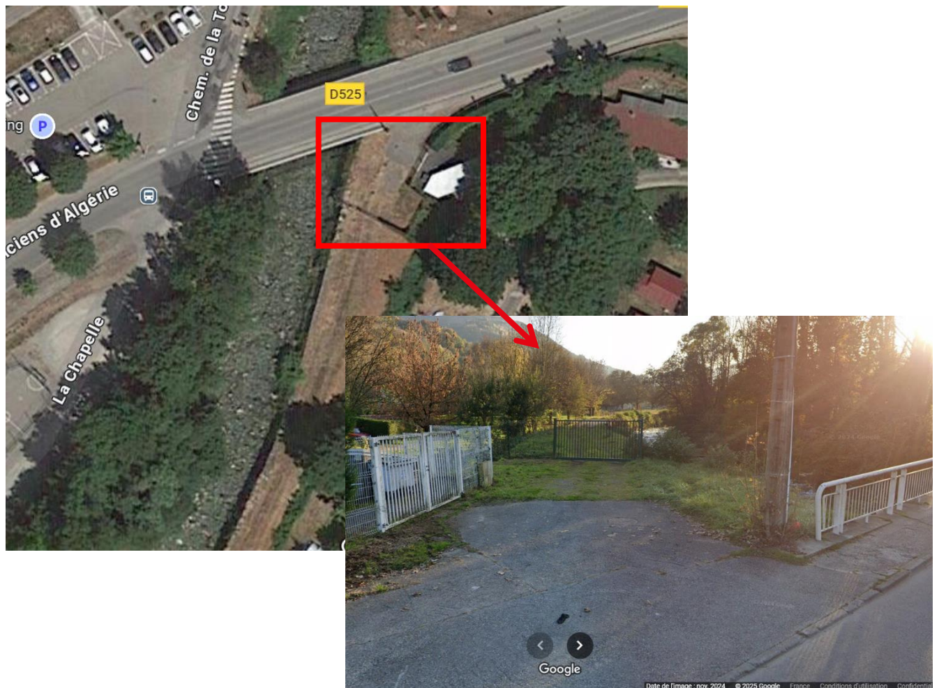
Figure 61 : Accès au chantier
