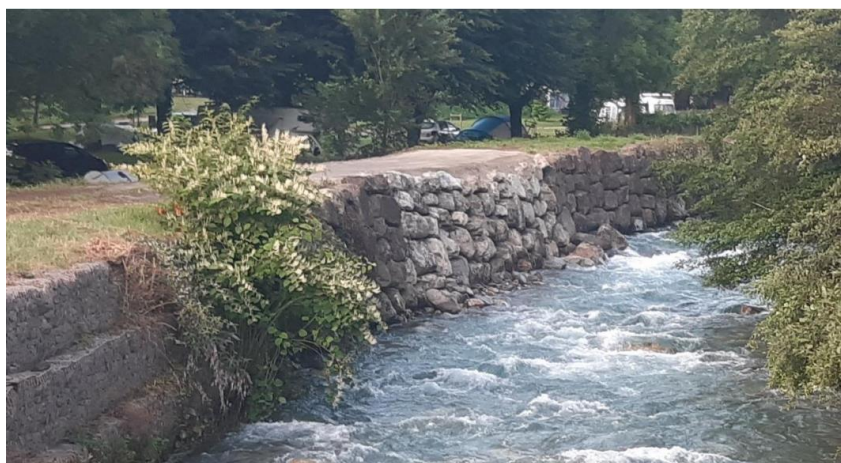
Figure 12 : Confortement de la digue en enrochements libres (vue depuis le pont de la RD525)
