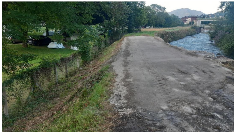
Figure 11 : Confortement de la digue en enrochements libres (côté terrain naturel)
