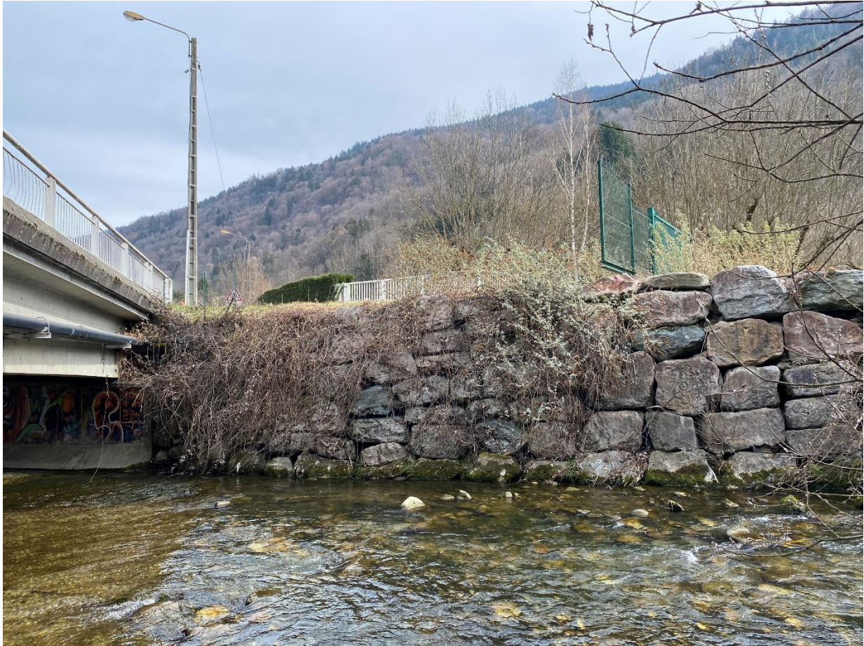
Figure 32 : Liaison digue – mur pont RD525
