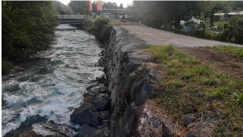
Figure 10 : Confortement de la digue en enrochements libres (vue depuis l'amont côté cours d'eau)
