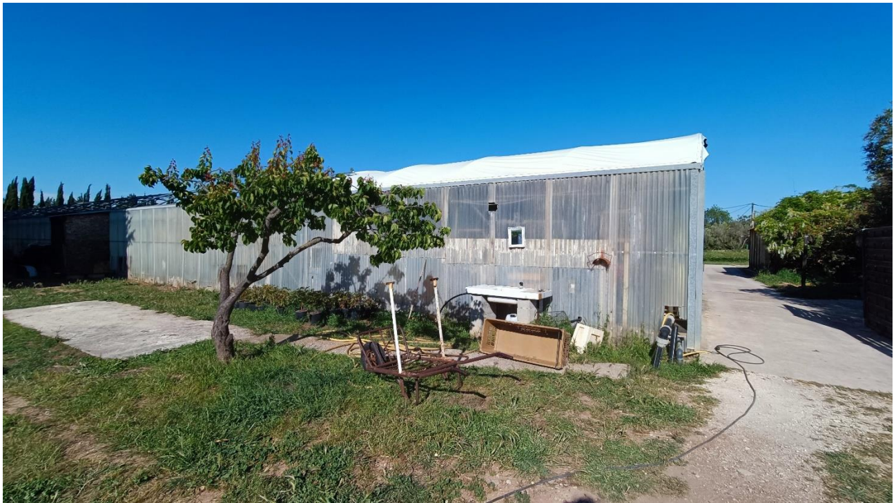
Photographie 3 : Un des bâtiments situé au centre de l'aire d'étude, Eco-Stratégie le 24/04/2024
