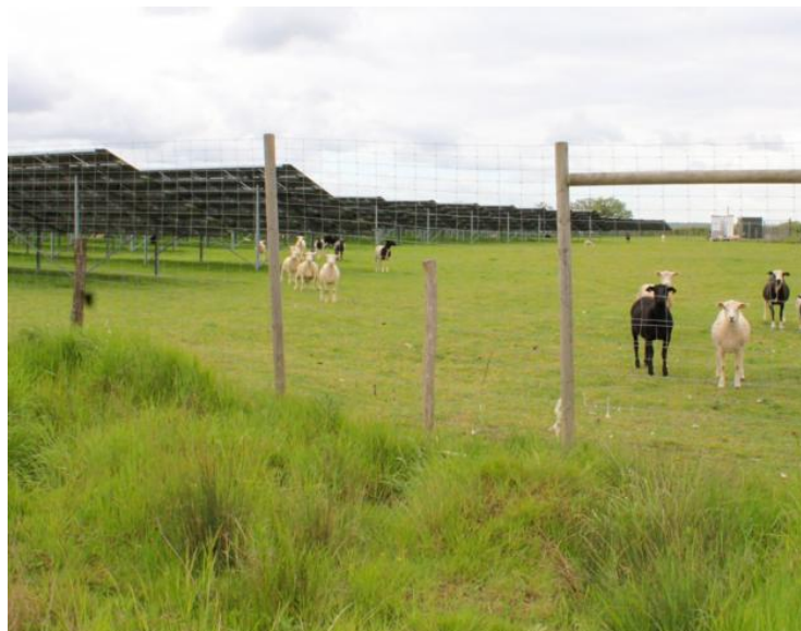
Figure 2 : Clôture à grosse maille installée dans une centrale agri-voltaïque - Source Corieaulys
