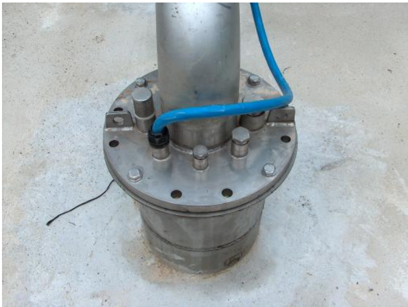
Tête de forage métallique étanche
