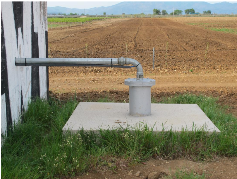
Tête de forage métallique - Dalle béton armé 3 m²
