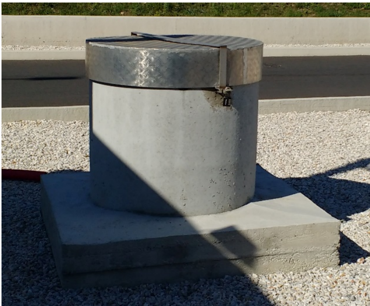
Exemple de regard de protection de puits/forage
