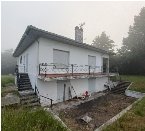
Figure 34 : Bâti de la parcelle Nord (Source : GEOCIAM)
