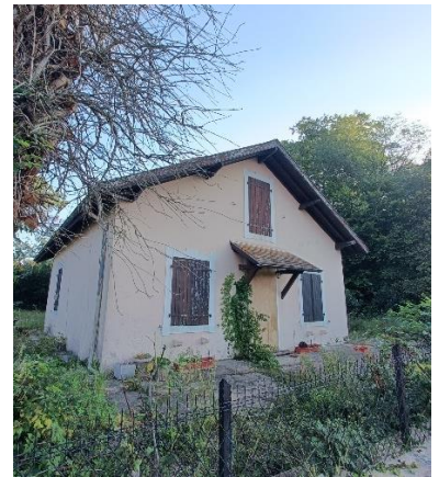
Figure 36 : Bâti de la parcelle Sud (Source : GEOCIAM)
