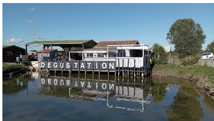
Figure 30 : Photographie de l'habitat « J2.4 - Bâtiment ostréicole » (Eau-Méga, 2025)
