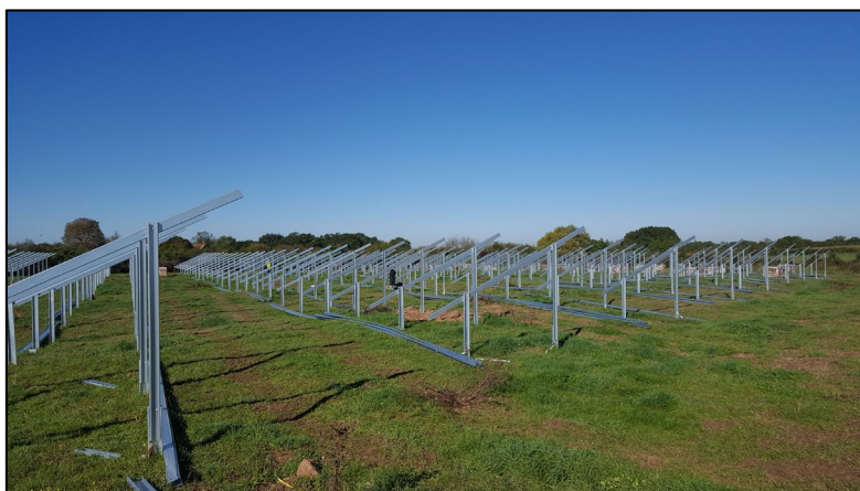
Mise en place des structures sur pieux battus (centrale JPee de Braize, 03)
