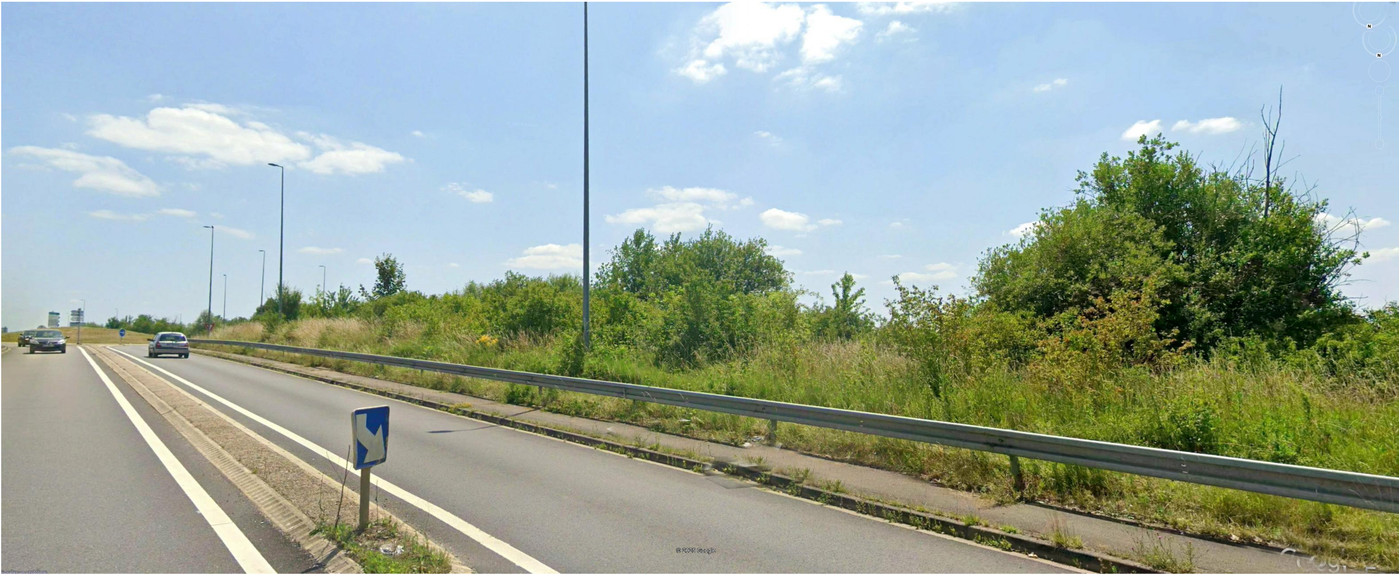
Vue 1 Vue vers le Sud
