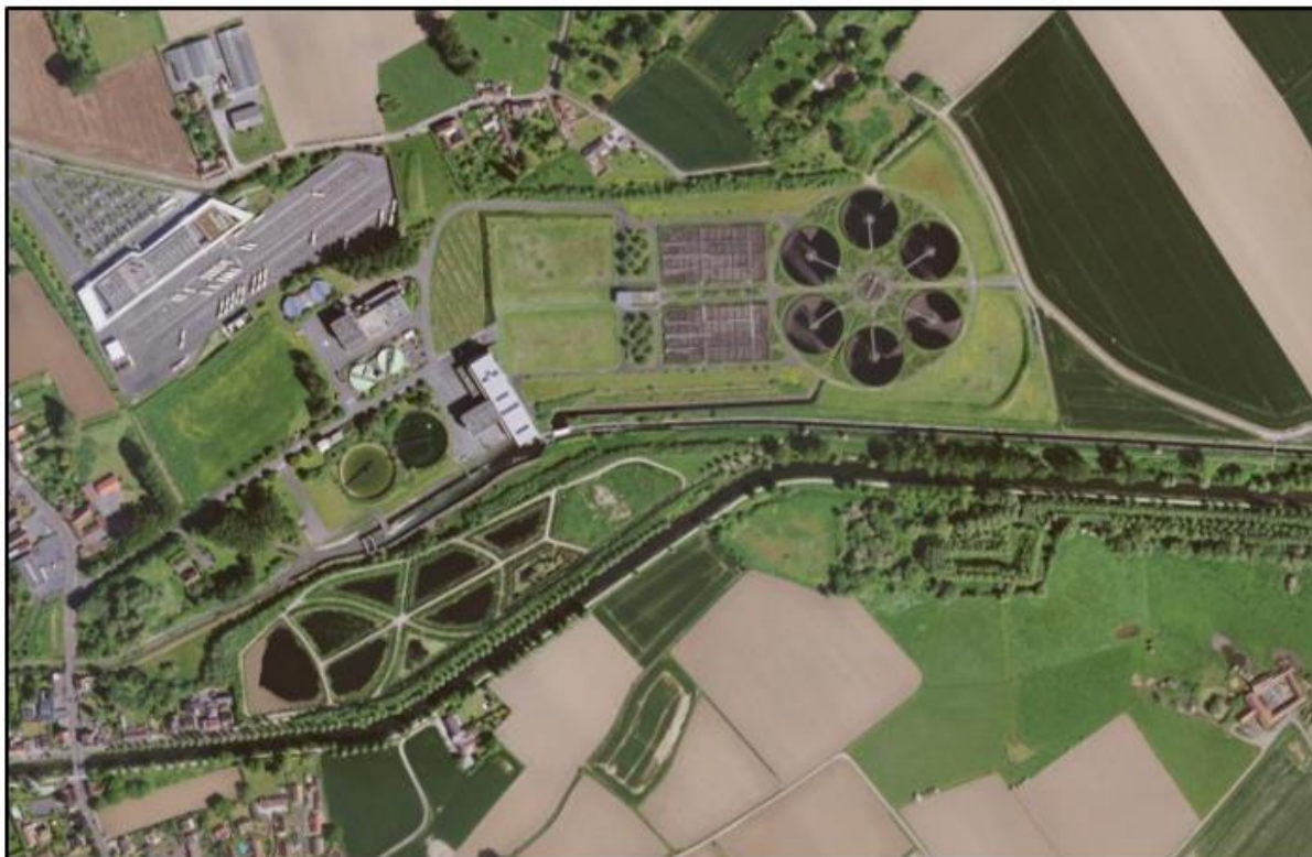
FIGURE 3 - VUE AÉRIENNE DE LA STATION D'ÉPURATION DE WATTRELOS GRIMONPONT — SOURCE GEOPORTAIL
