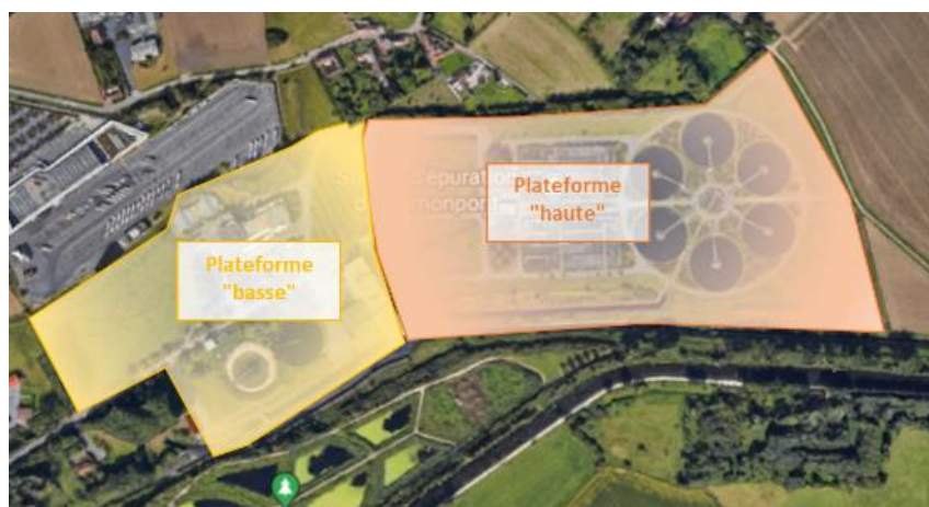
FIGURE 63 DÉLIMITATION ZONES "PLATEFORME BASSE" ET "PLATEFORME HAUTE" SUR VUE SITE STEU (SOURCE : GOOGLE EARTH)
