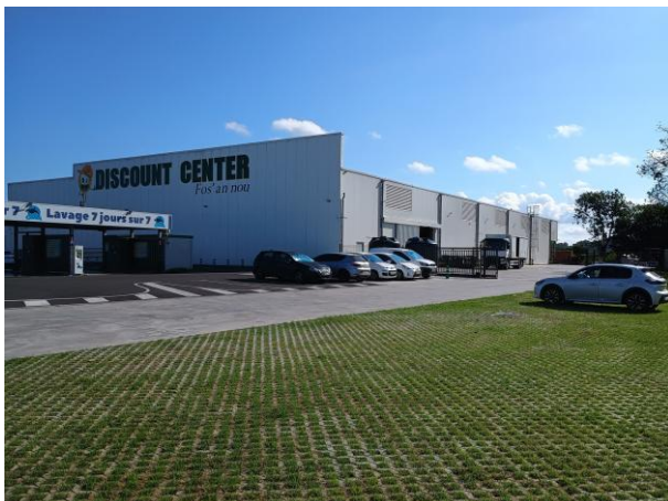
Vue sur la voie d'accès au Discount Center
