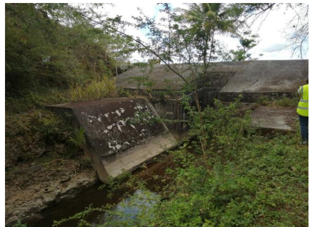
Vue sur l'ouvrage de régulation bétonné
