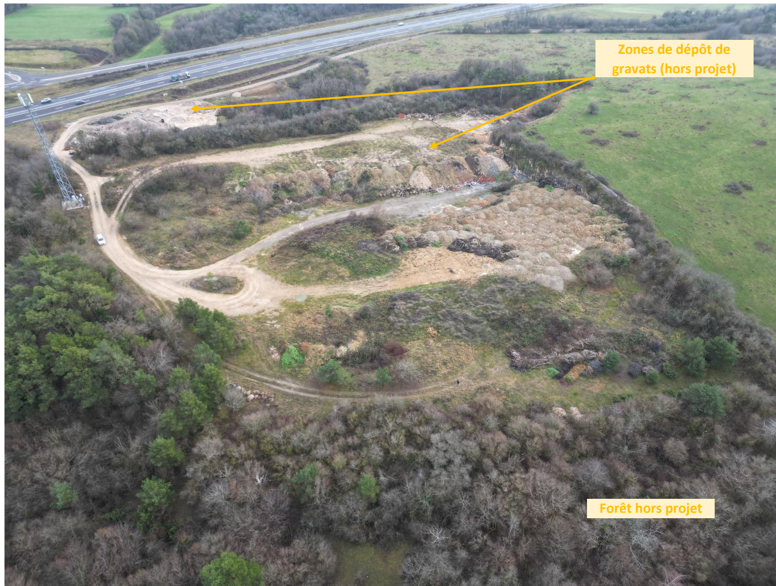
Insertion 1 – Vue depuis le Nord– photo initiale – 11/12/225
