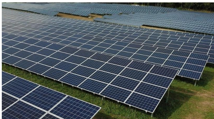
Figure 4 : Exemple de table photovoltaïque sur pieux en 4H
