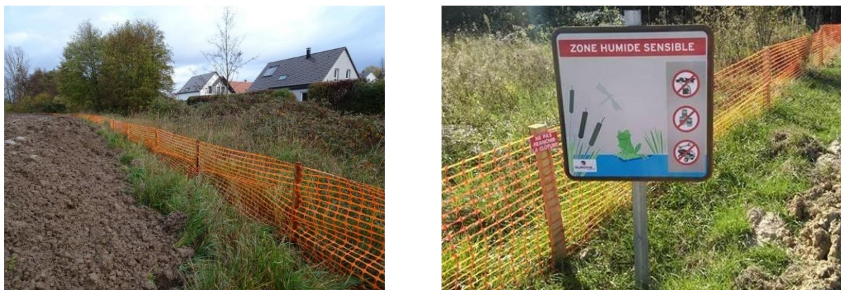
Figure 37 : Photographie d'exemples types de mis en défens/balilage des espaces préservés – source : SERUE Ingénierie, 2023
