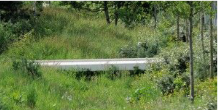
bassin de rétention
