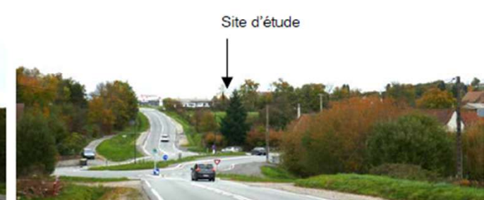
Vue 4 depuis la Route départementale en venant d'Aubusson
