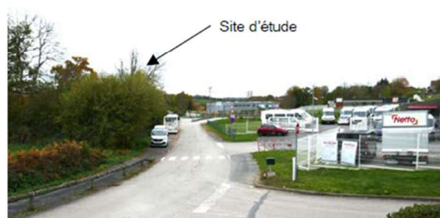
Vue 5 depuis la ZAC du Mont, chemin du Mont
