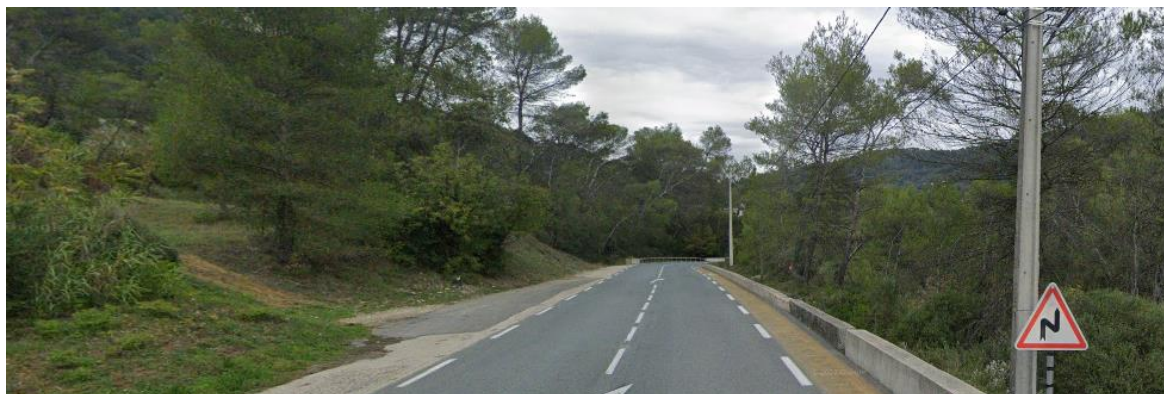
Route D2204 à hauteur de la déchetterie communale de Contes (source : google maps)
