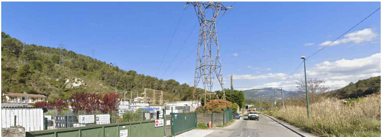
Photo du poste électrique de Contes et de la route qui y mène (source : google maps)
