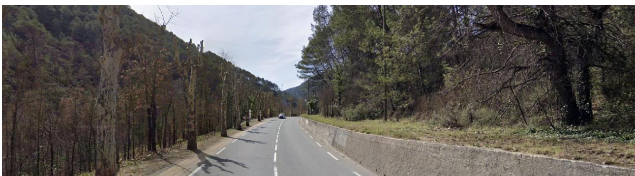
Route départementale 2204 au nord du Destey (source : google maps)
