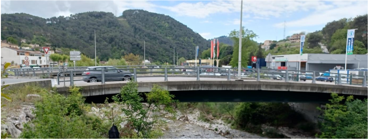
Pont permettant le franchissement de la RD 2204 au-dessus du cours d'eau du Paillon de Contes
