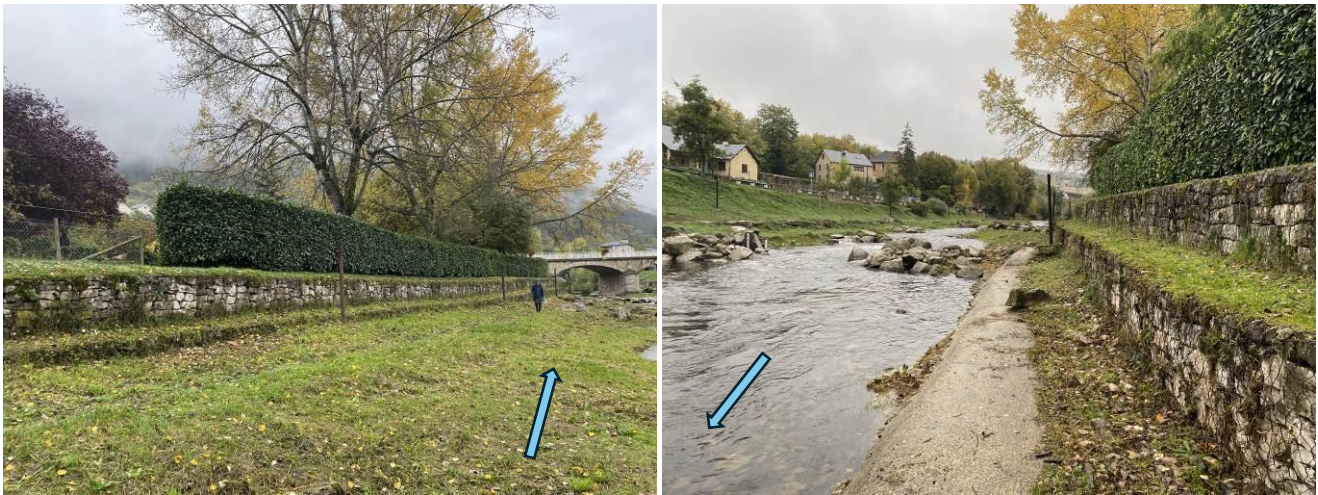
Fig.5 et 5bis Vues du pied de berge gauche et des ouvrages à démonter en amont de l'Ancien Pont Roupt (Biotec octobre 2023).
