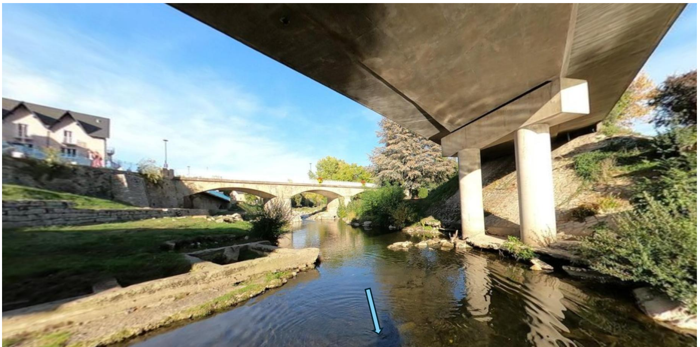
Fig.6 Vue du perré à démonter du Nouveau Pont Roupt et Ancien Pont Roupt en arrière-plan (SMLD 2023)
