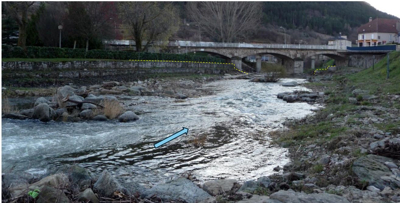
Fig.3 Vue actuelle de l'Ancien Pont Roupt montrant le remblai et les protections par gabions. Le Nouveau Pont est perceptible en arrière-plan (photo 2011).
