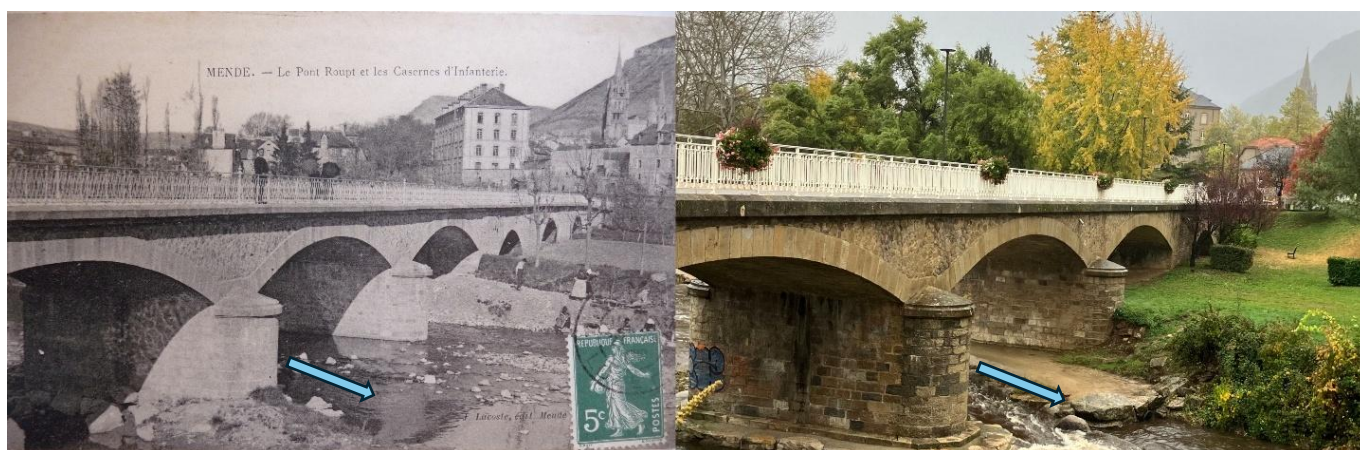
Fig.4 Photos de 1907 et de 2025 montrant le Pont Roupt à sept arches. La régression des dépôts sédimentaires au pied de la 1ère pile illustre le changement d'axe d'écoulement préférentiel.
