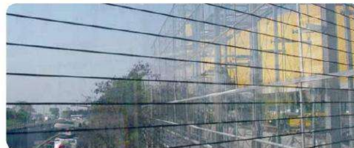
Des lignes noires horizontales d'une épaisseur de 2 mm avec un espace de 28 mm ont obtenu, contre toute attente, de bons résultats en laboratoire. Lorsque la visibilité doit rester maximale, cela pourrait être une bonne solution.
