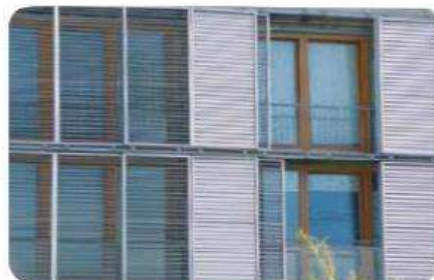
Ces stores déplaçables latéralement évitent la surchauffe et empêchent les collisions des oiseaux.
