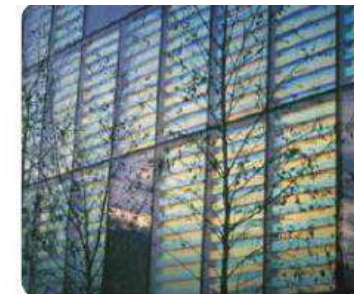
Des lamelles de film plastique réfléchissant la lumière sont placées entre les verres et forment un élément décoratif.
