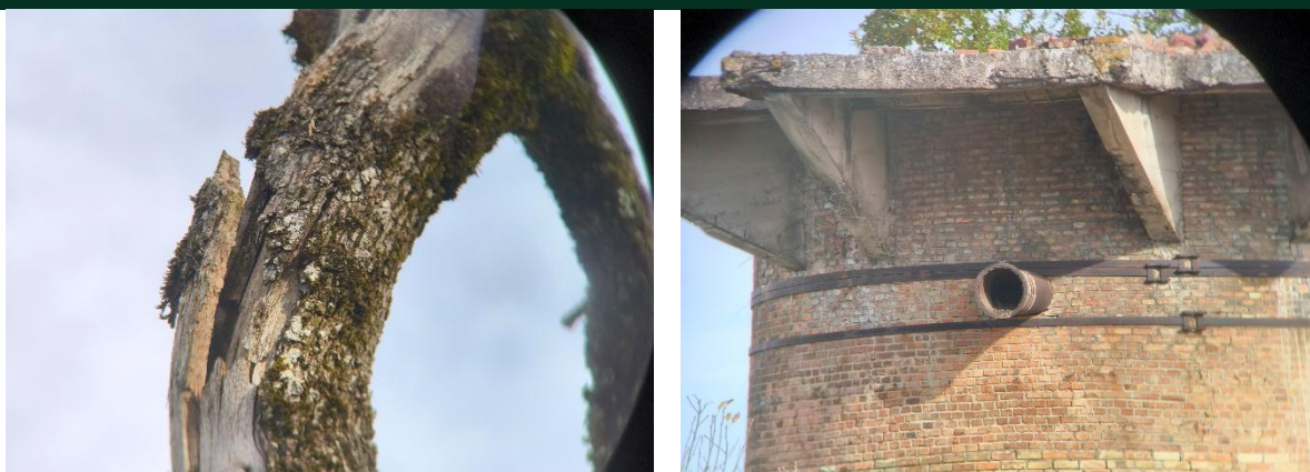
Fente de tronc (à gauche) et ancien four à chaux (à droite) favorables au gîte des chiroptères
